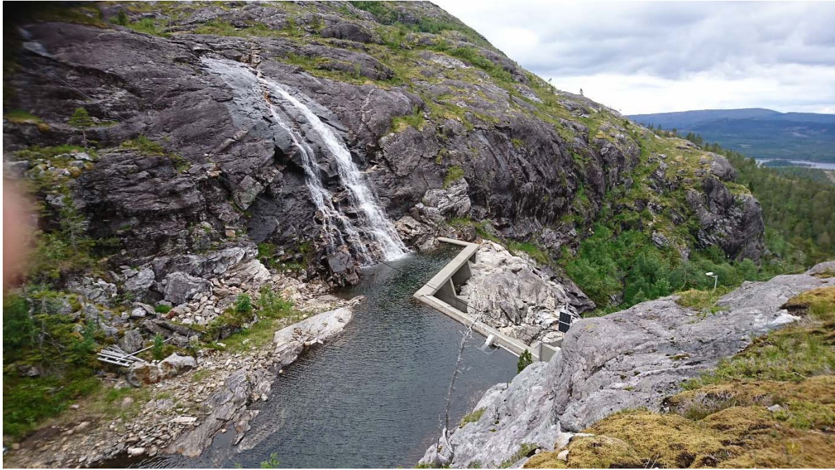
Sperredam ved inntakstjern Søberg kraftverk
