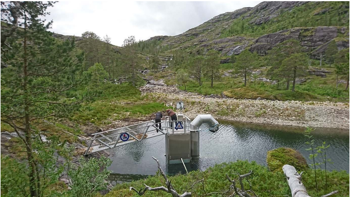
Inntak Søberg kraftverk
