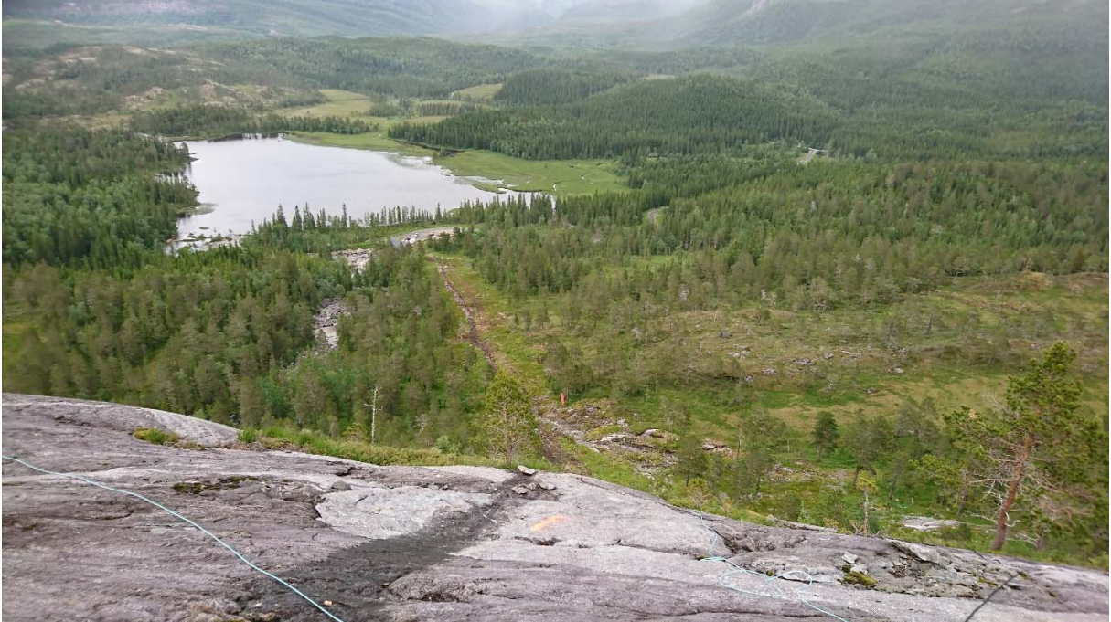
Søberg kraftstasjon sett ovenfra
