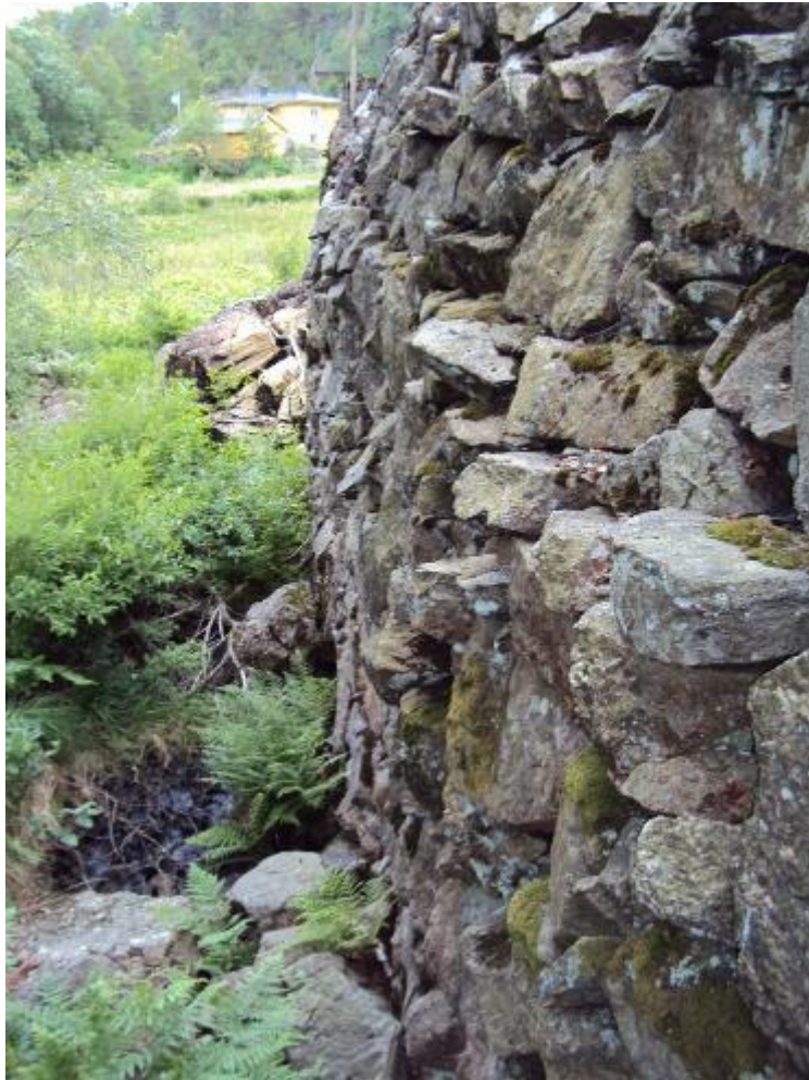
Foto 3 Steinfyllingsdam med naturstein (Sweco 2017).
