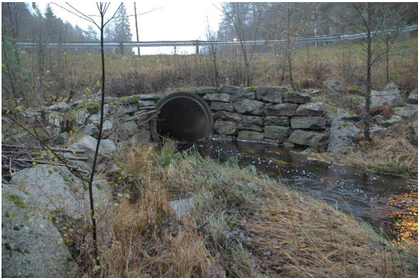
Foto 54 Kulvert 2 i vassdraget nedstrøms Lonan.
