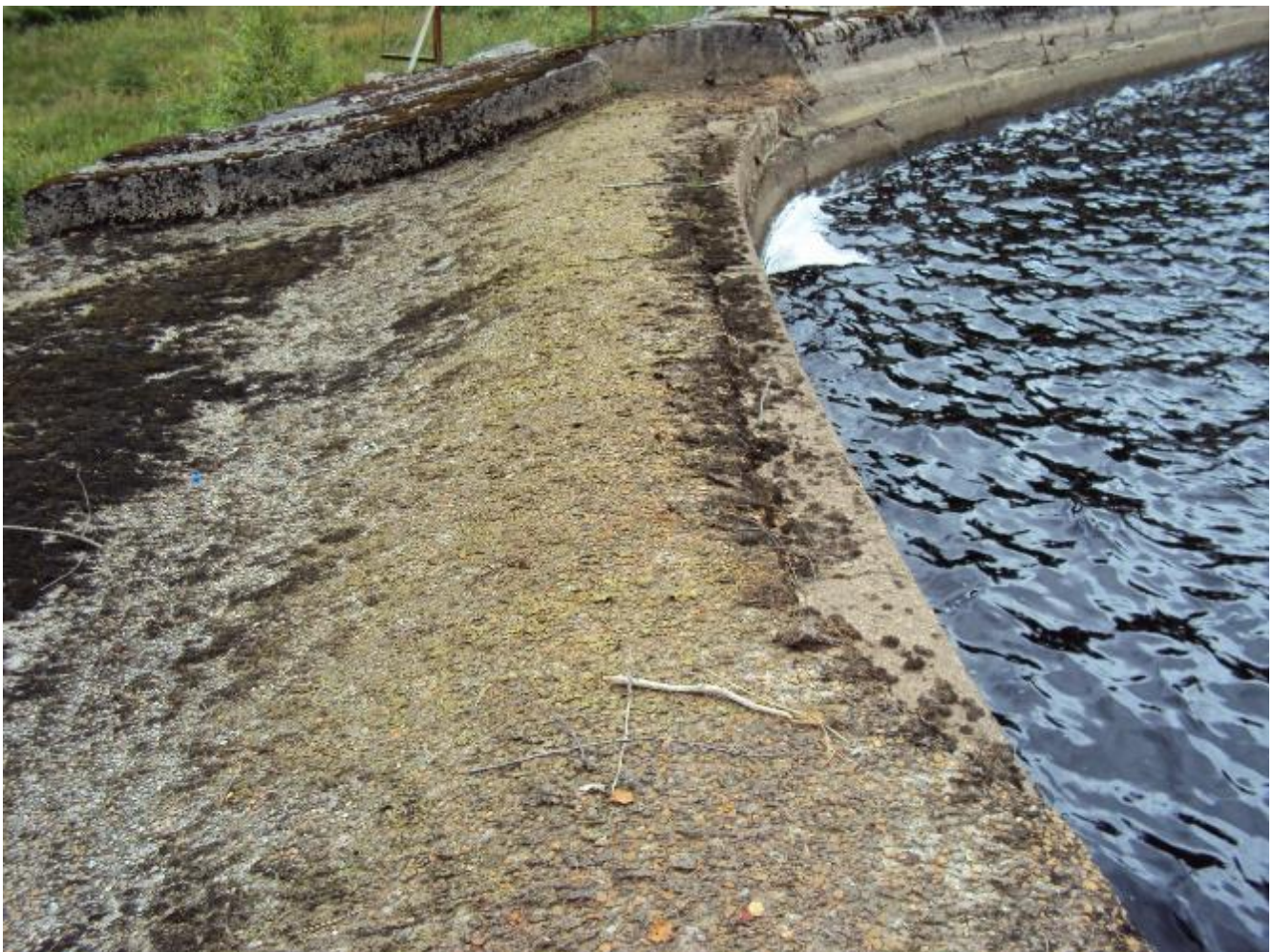
Foto 10 Dam Lonan. Tørt flomløp (Sweco 2017).
