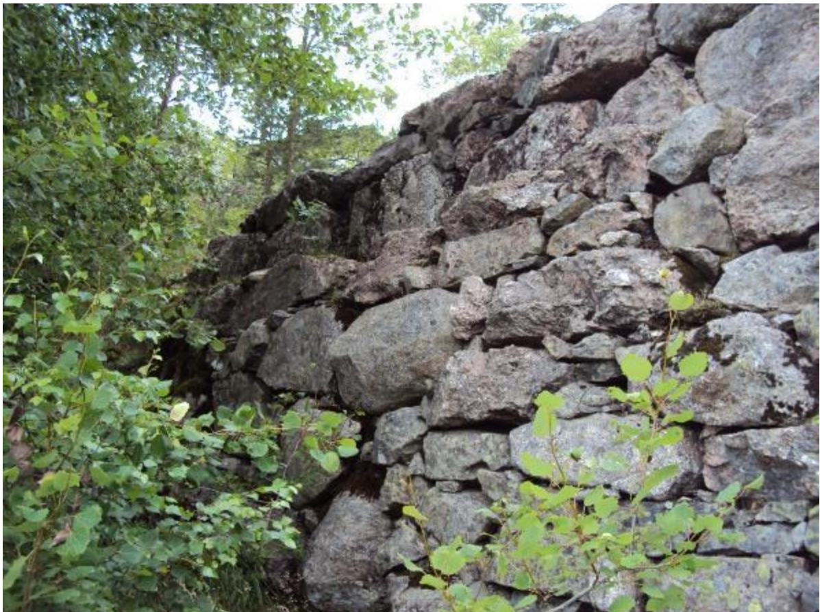
Foto 4 Steinfyllingsdam av naturstein (Sweco 2017).
