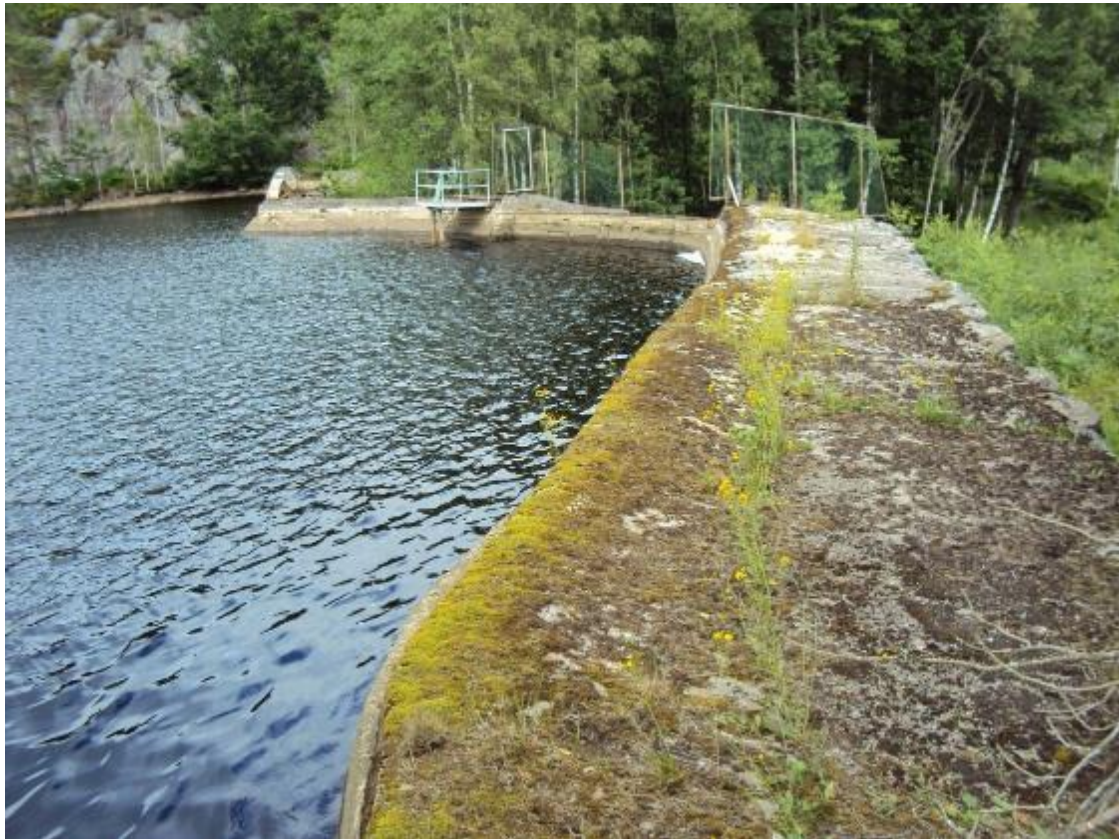
Foto 1 Dam Lonan sett mot flomløpet (Sweco 2017).
