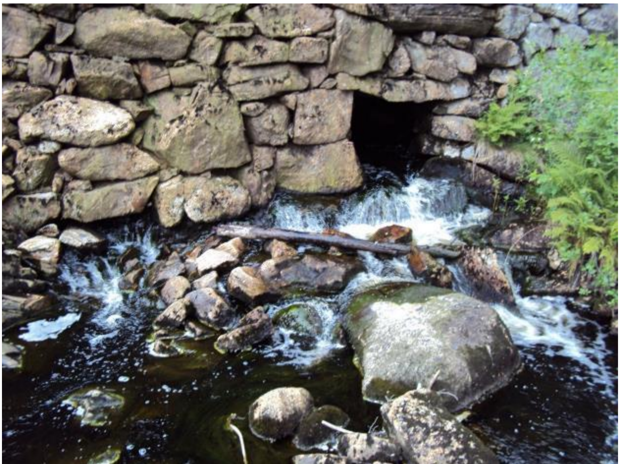
Foto 22 Utett eller åpnet bunnluke (Sweco 2017).
