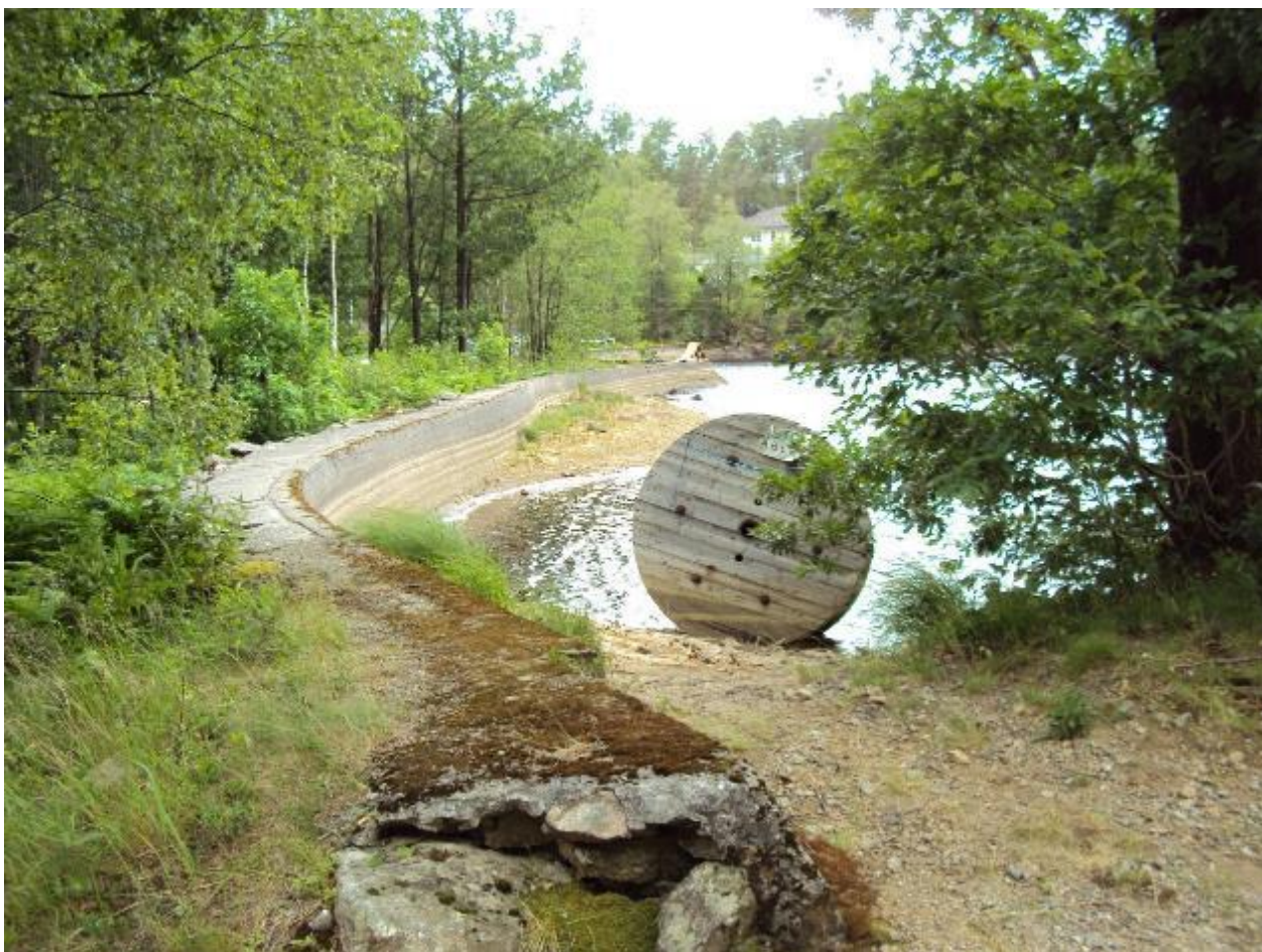
Foto 6 Dam Lonan. Oppstrømside med grusforekomst på vannside og noe etablert vegetasjon under HRV (Sweco 2017).
