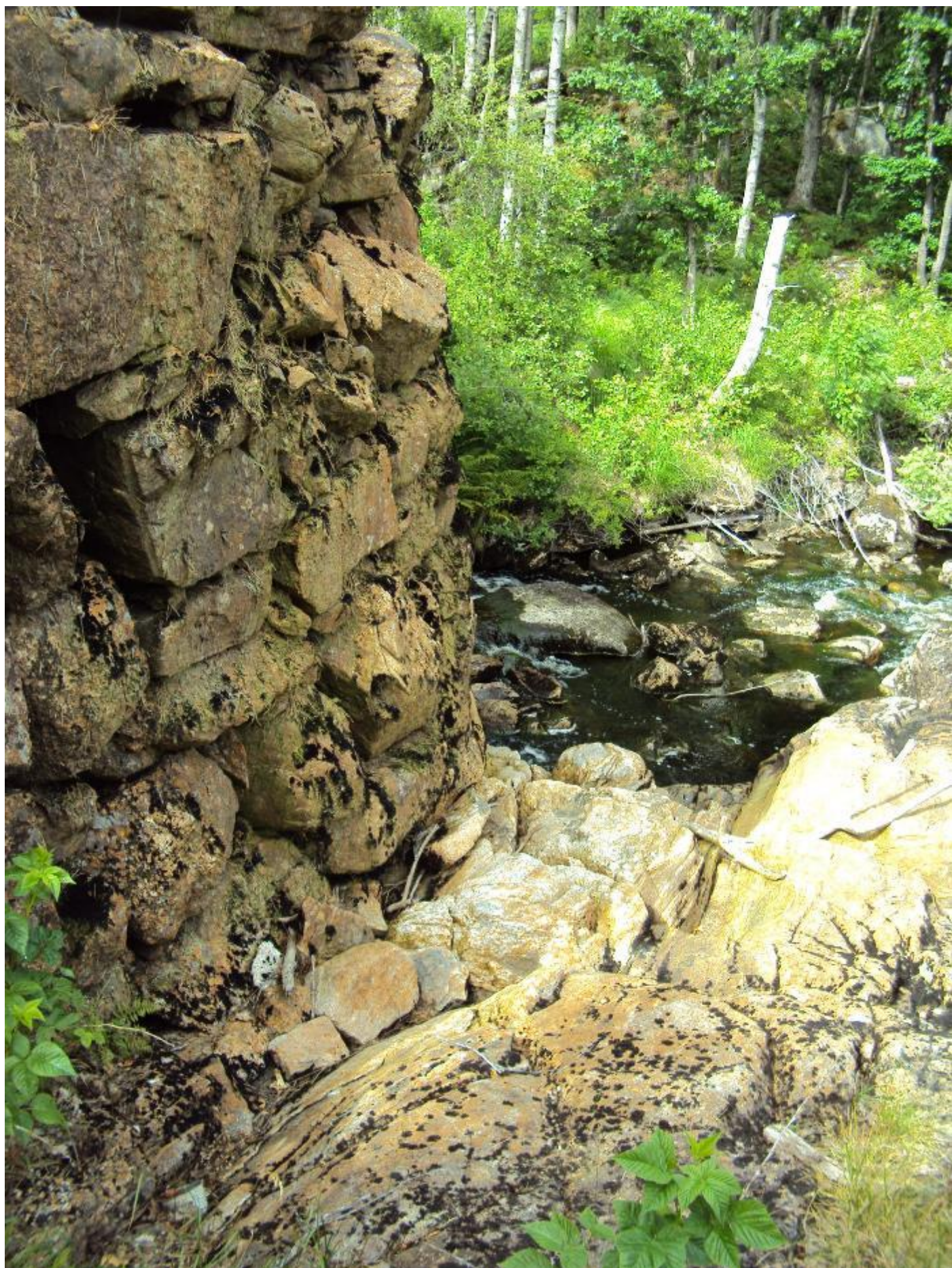
Foto 19 Utløp bunntappeluke og område nedenfor overløpe (Sweco 2017).
