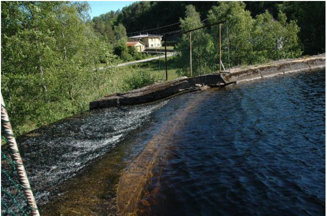
Foto 9 Flomløp dam Lonan.
