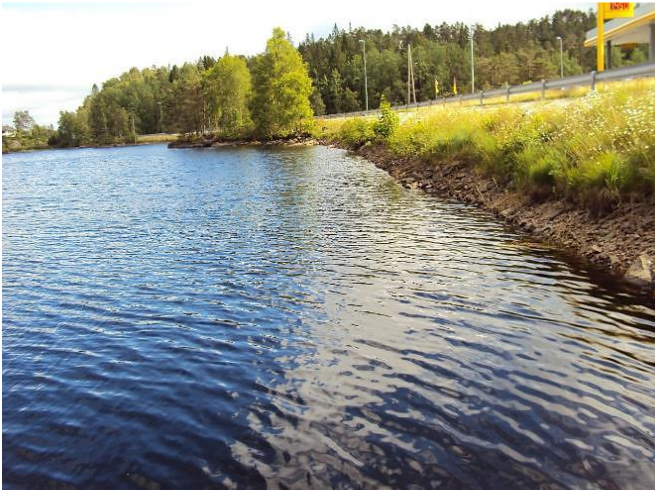
Foto 37 Lona sett mot syd med vannstand under HRV. Rv9 på fyllingen til høyre (Sweco 2017).
