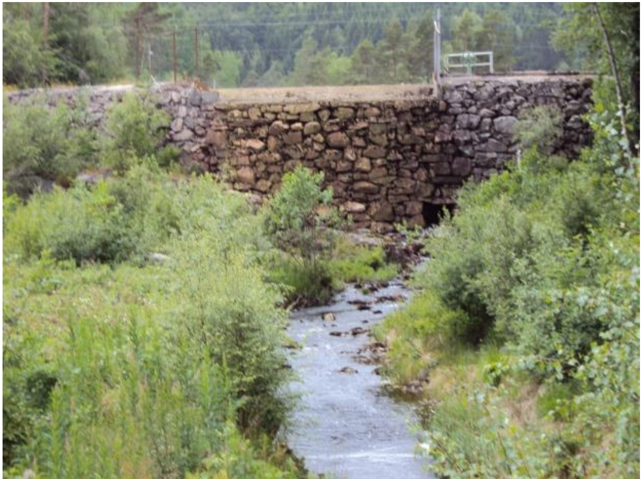
Foto 21 Overløp, bunntappeløp og utløpsbekk (Sweco 2017).
