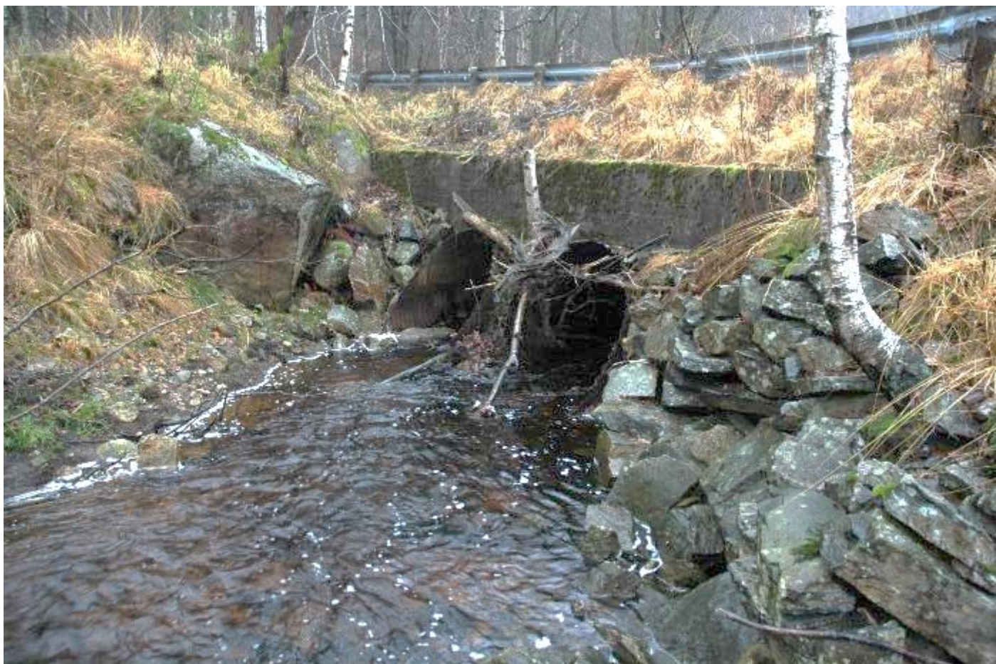
Foto 53 Første kulvert under Setesdalsveien rett nedstrøms dam Lonan.
