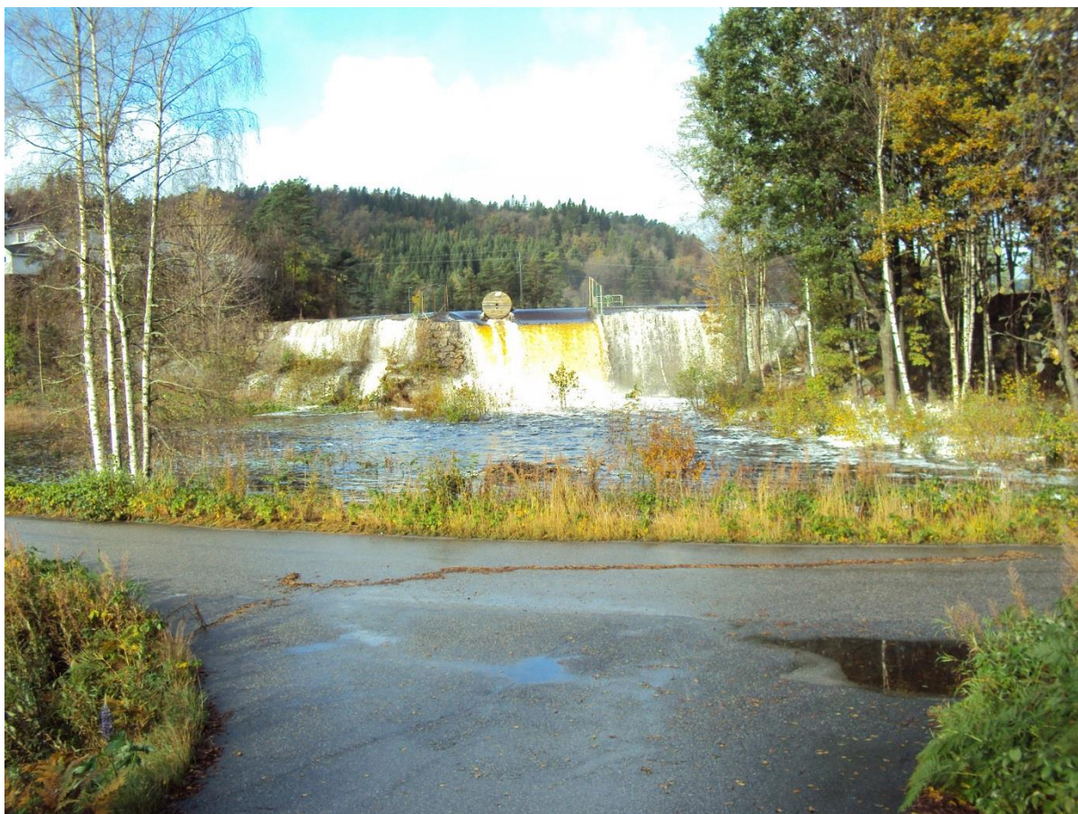
Figur 3.3 Overtopping av dam Lonan og oversvømming av innmark ved flom 2017. Kulverten under Setesdalsvegen har begrenset kapasitet eller er blitt tilstoppet. Merker etter maksimal flomvannstand over veien vises i form av avsatt materiale på Setesdalsvegen (Foto: Sweco 2017).
