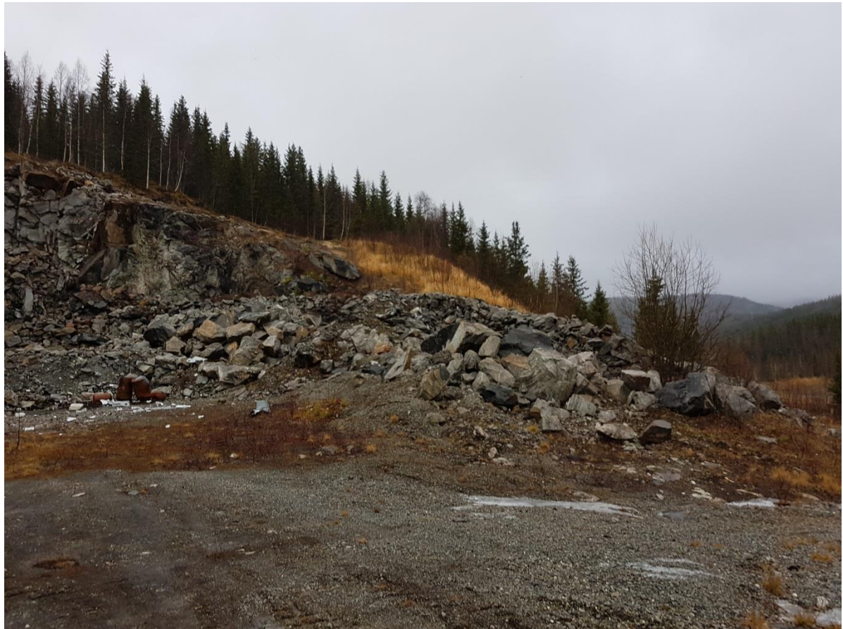
Figur 23: Eksisterende massetak langs Tveråvegen som Tiltakshaver ønsker å utvide.
