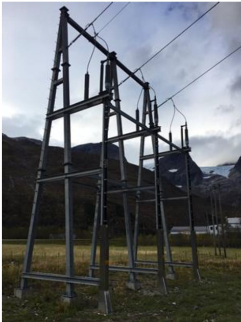
Figur 8. Kabelendemast i stål (bilde)
