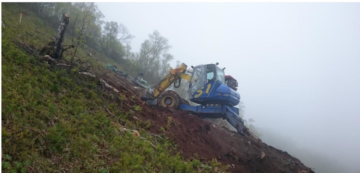
Figur 14. Graving for fundament i svært bratt terreng.
