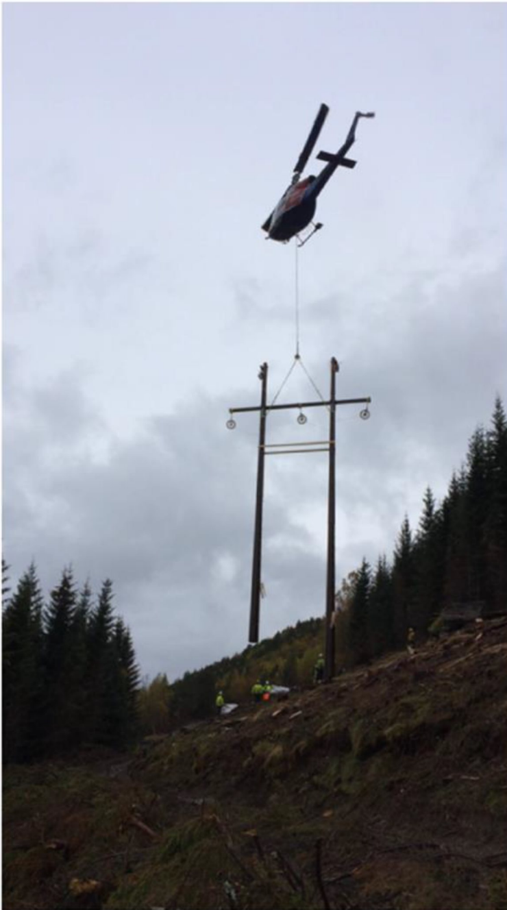
Figur 15. Ferdige stolper flys inn til stolpefestet med helikopter.
