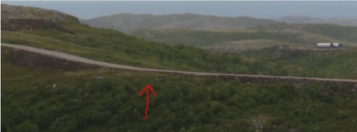
Figur 5: Et eksempel på en vei som er bygget på fylling, men hvor terrenget bryter fyllingen. Resultatet er en vei som er godt tilpasset landskapet. (NVE)
