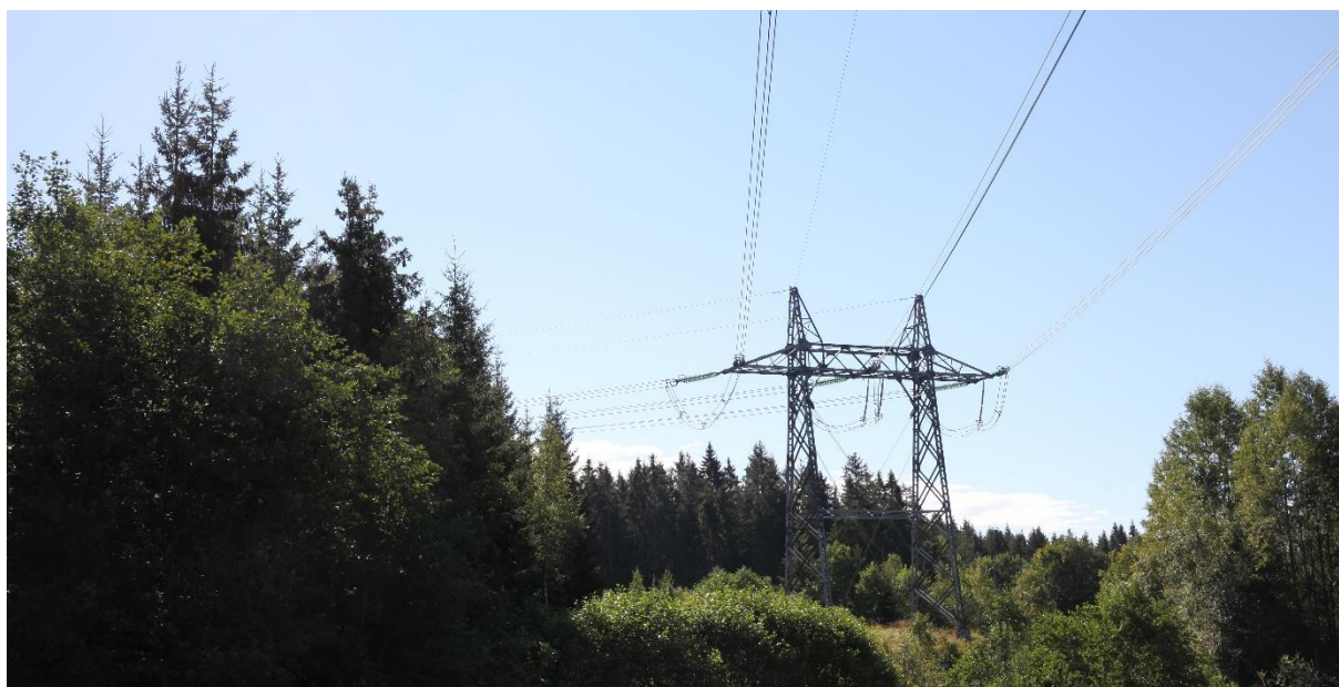
Figur 5: Dagens forankringsmaster over Liåsen. Nye, permanente forankringsmaster vil se like ut.
