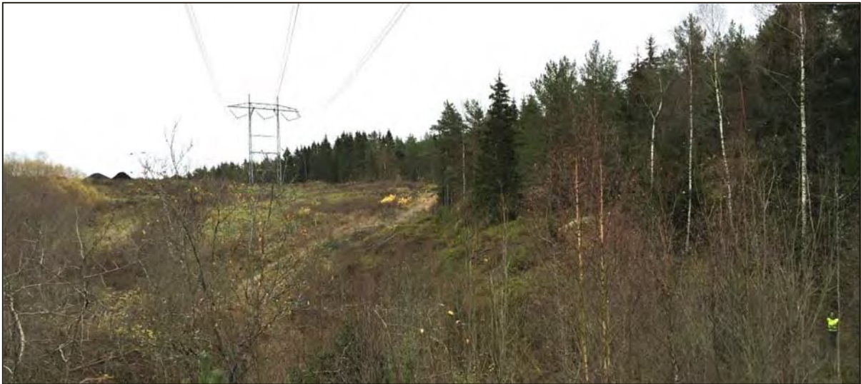
Figur 6-8. Alternativ 8 med anlegget inn i skogen til høyre og hitenfor for masta, mens veien vil gå opp hellinga mot masta fra venstre mot høyre. Bildet er tatt mot sør-øst. Foto: T.E. Høvdning, Multiconsult.
