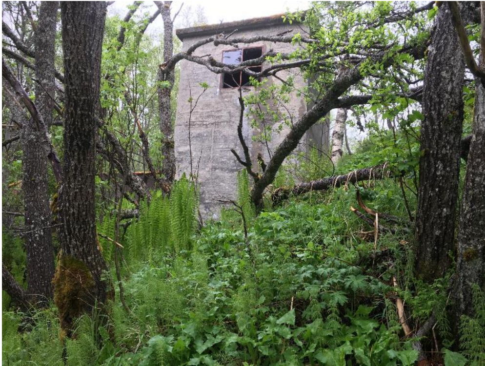
Figur 2 Demningen og lukehuset sett nedenfra. Lukehuset har innvendige mål 2,75 * 4,20 meter.
