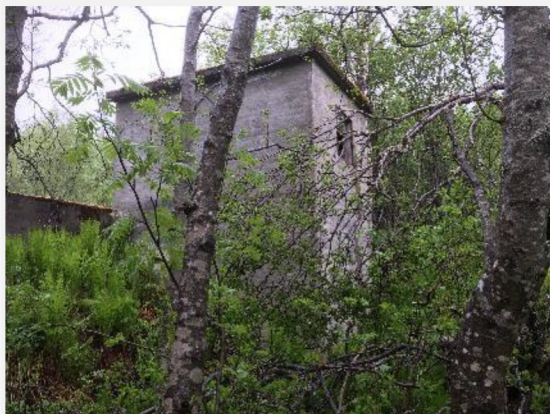
Demning med lukehus sett nedenfra.
