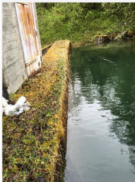
Vestre del av demningen med overløp.
