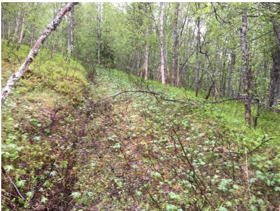
Figur 8 Den gamle anleggsveien fra 1957 er delvis gjengrodd med busker og småtrær, men grei å finne.
