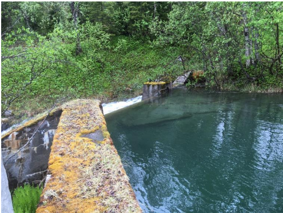
Figur 3 Overløpet ligger langs elvas vestbredd. Dybden ved overløpet er på bildet 0,3 – 1,0 meter. Det synes å være fjell på bunnen ved overløpet. Vannivået på bildet (tatt 17/6-2017) er 50 cm under overkant damkrone.
