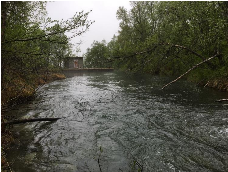
Figur 5 Vannmagasinet sett nordfra
