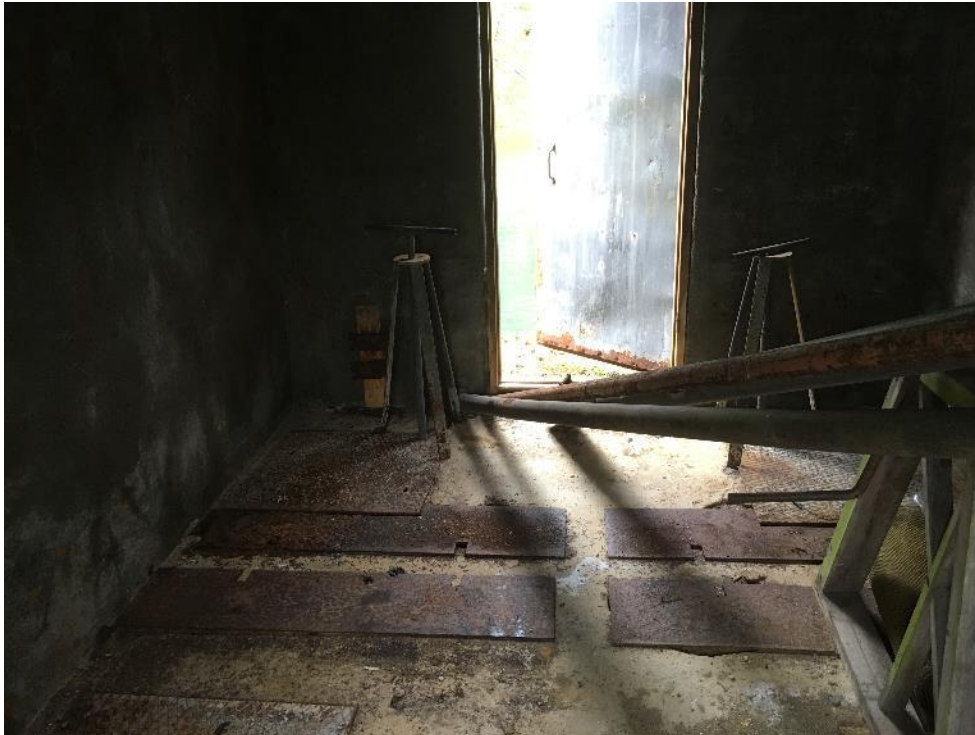
Figur 4 Inne i lukehuset er det mange luker i gulvet. Under gulvet er det en rekke lukekamre. Den kvadratiske luken oppe til høyre i bildet er åpnet og kammeret inspisert. Lukekammeret var 1,2 m bredt og 1,0 m langt. I bunnen av kammeret er det et 300 mm stålrør. Høyden fra overkant stålrør til overkant betongdekke var 5,63 meter, slik av høyden fra kammerbunn til overkant betongdekke er ca. 6,0 m.
