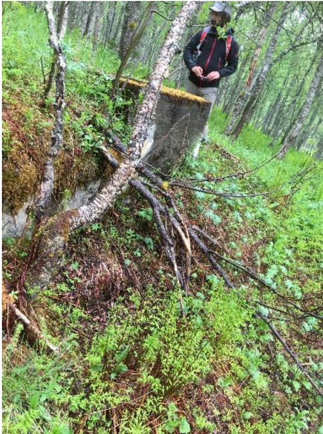
Figur 7 Ventilummen av betong ligger ca. 60 m nedenfor demningen. Det går to 300 mm rør fra lukehuset og frem til ventilummen. Ventilummens indre mål er 2,8 *2,0 meter. Høyden er ca. 1,5 meter.
