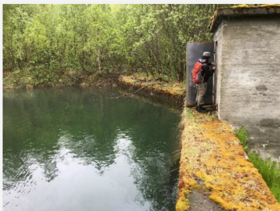
Østre del av demningen med lukehus. Bredden på den mosegrodde betongen på bildet er 100 cm.
