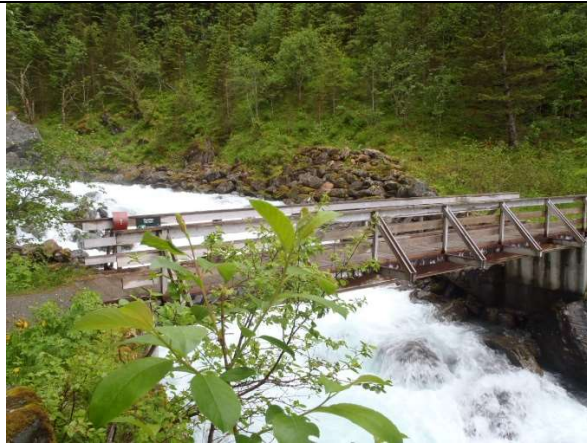
Brua og damstedet
