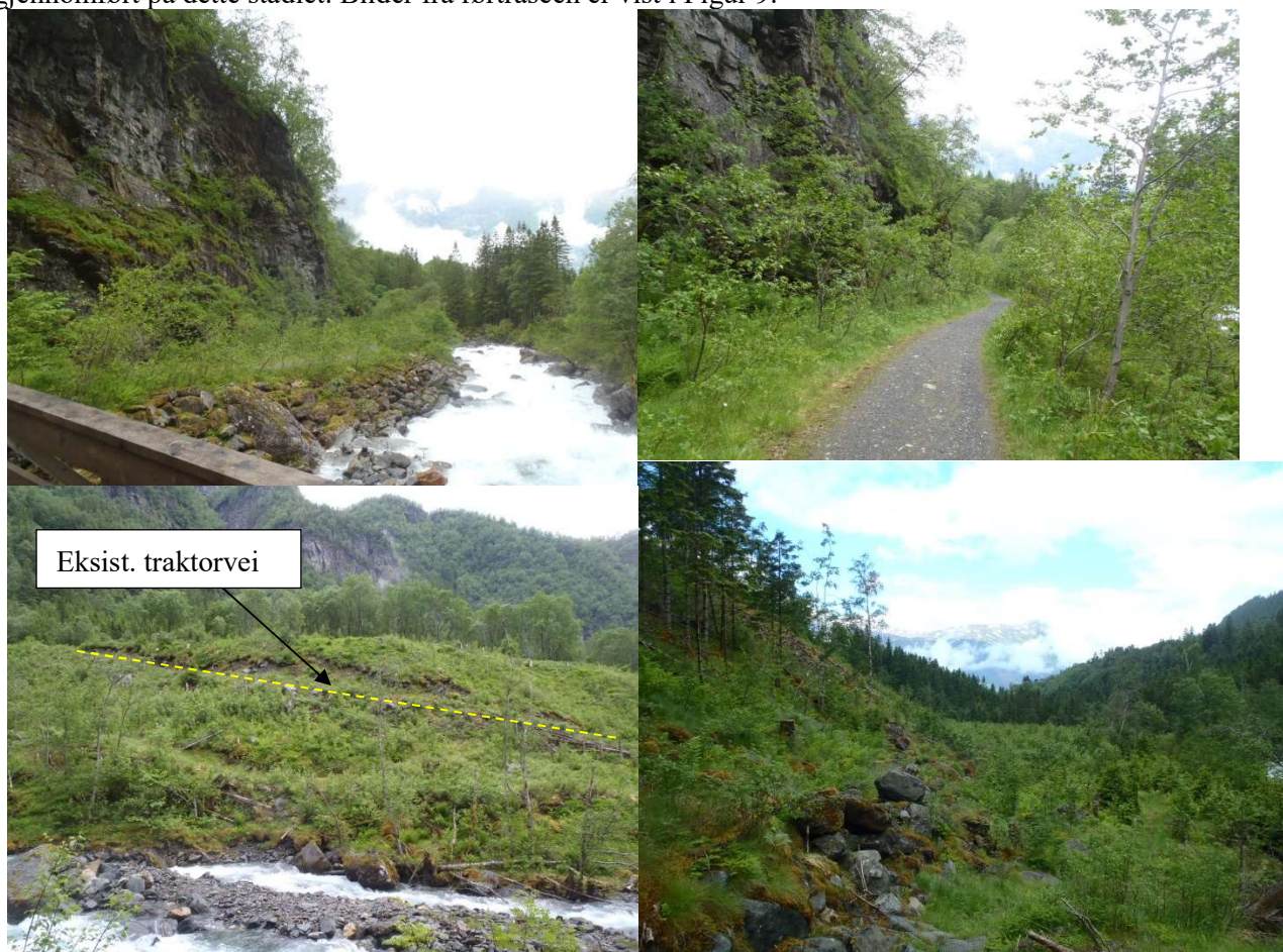
Figur 9. Øverst til v.: Rett etter inntak, til h.: strekningen hvor sprenging påregnes. Nederst til v.: rørtrase ca. midt i strekningen, langs traktor vei, til h.: rørtrase nederst.
