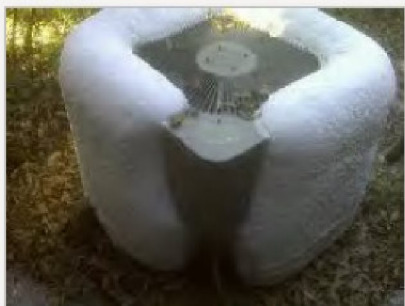
Gjenfrysing av luftfordamper
