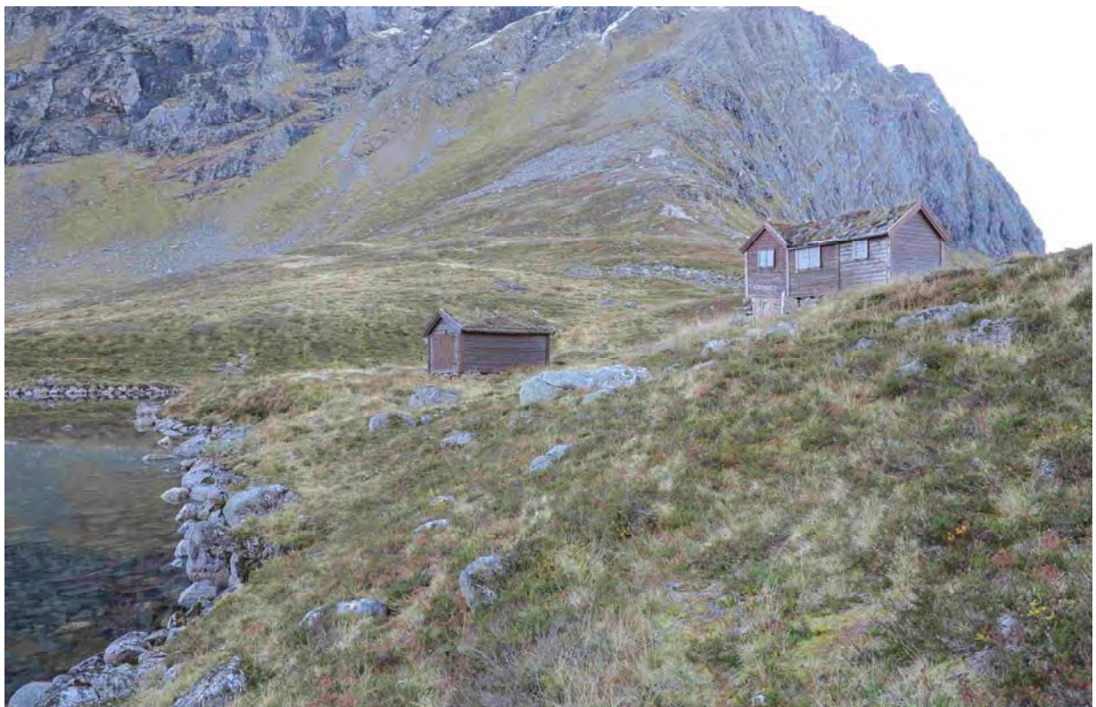
Figur 127. Foto; Oddvar Olsen for Bioreg AS © 07.10.2016. Biletet viser eit naust og ei hytte som er bygd like ved utlaupet av vatnet. Slik planane ligg føre, så er det meininga at ein skal unngå å måtte flytta naustet lenger frå vatnet enn det no står.
