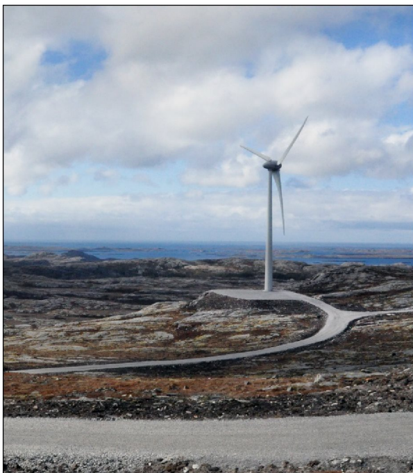
Figur 20. Minst mulig eksponering av kranoppstillingsplass og fundament er viktig for god landskaps-tilpasning, her vist ved senking av oppstillingsplass slik at utstrakte fyllinger unngås og gjenstående knauser delvis skjerner for innsyn.
