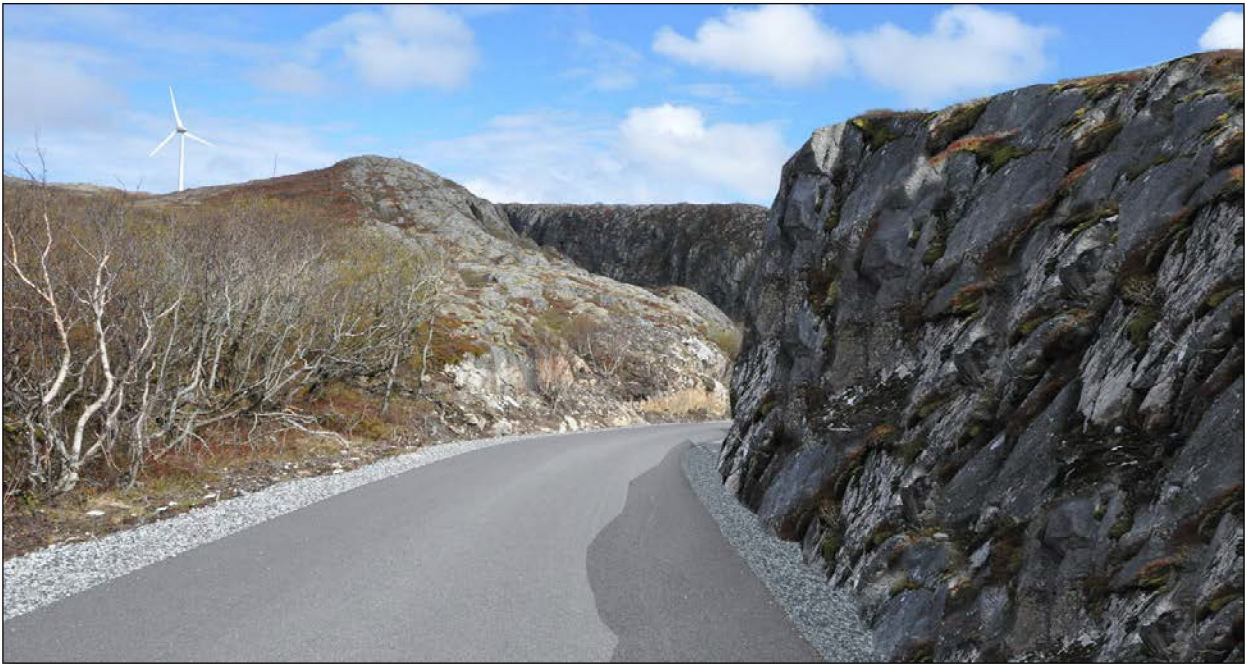
Figur 15. Manipulert bilde viser en tosidig skjæring der det ikke er gjort tiltak for å dempe den visuelle virkningen av skjæringen til høyre i bildet.
