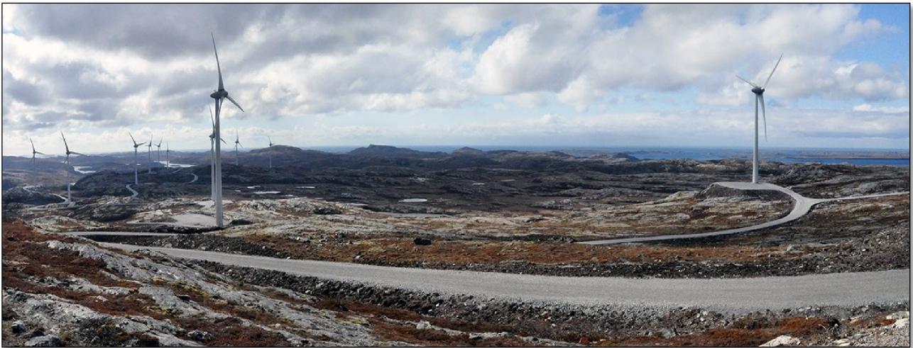
Figur 19. Panoramabildet viser kranoppstillingsplasser som generelt ligger godt i terrenget, med unntak av den ved vindturbinen til høyre i bildet som ligger noe høyt og blir dertil eksponert.
