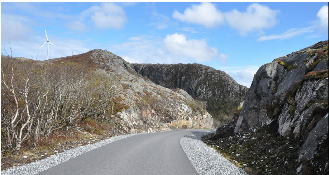
Figur 16. Dersom vegen må føres gjennom fjellparti og tosidige skjæringer ikke kan unngås, er det viktig at det settes av nok plass til at tverrsnittet føles romslig og skjæringene kan bearbeides i bunn og topp for å minske deres visuelle høyde og myke opp profilet. (Originalbilde fra asfaltert adkomstveg til vindkraftverket på Ytre Vikna)
