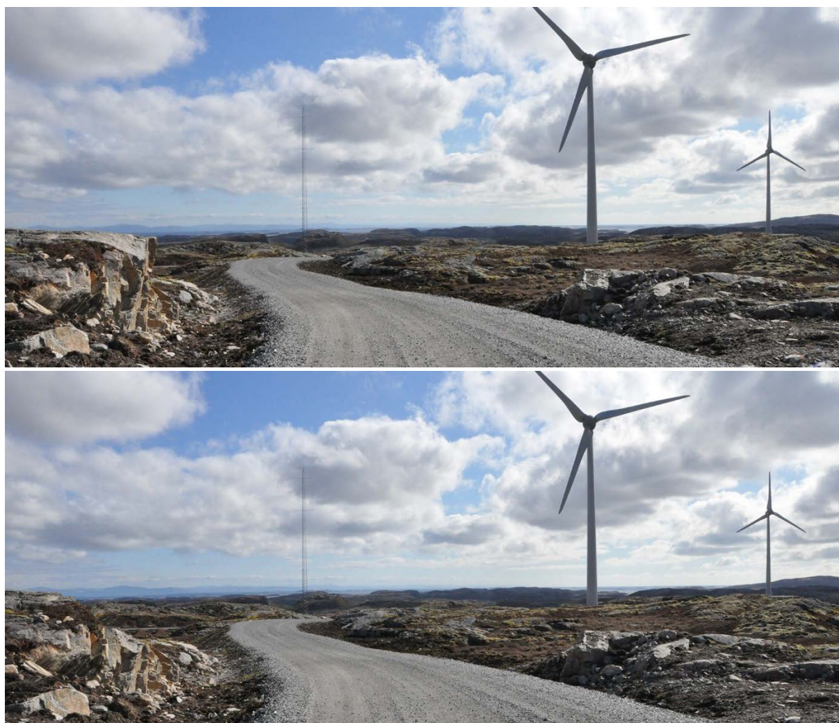
Figur 18. En mindre skjæring står igjen på venstre sida av vegen. Mindre pigging i toppen, som vist på manipulert bilde nederst, er alt som skal til for at oppstikkende nabber på begge sider av vegen skal bli mindre påfallende.
