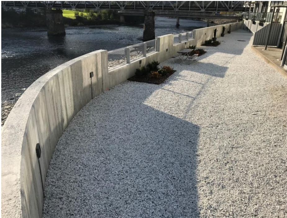
Bilde 3-3 Eksempel på flommur. Glassfeltene bryter opp og reduserer barrierevirkning. Foto: NVE.
