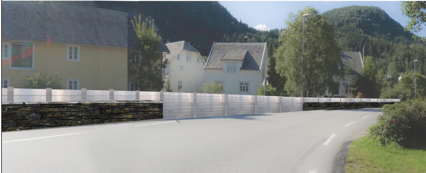
Flommur på Evanger påmontert mobile bjelkestengsel opp til kote 15,2
