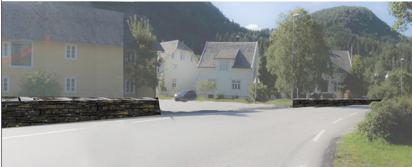
Flommur på Evanger i normalsituasjonen uten flom. Topp mur ca kote 14,5
