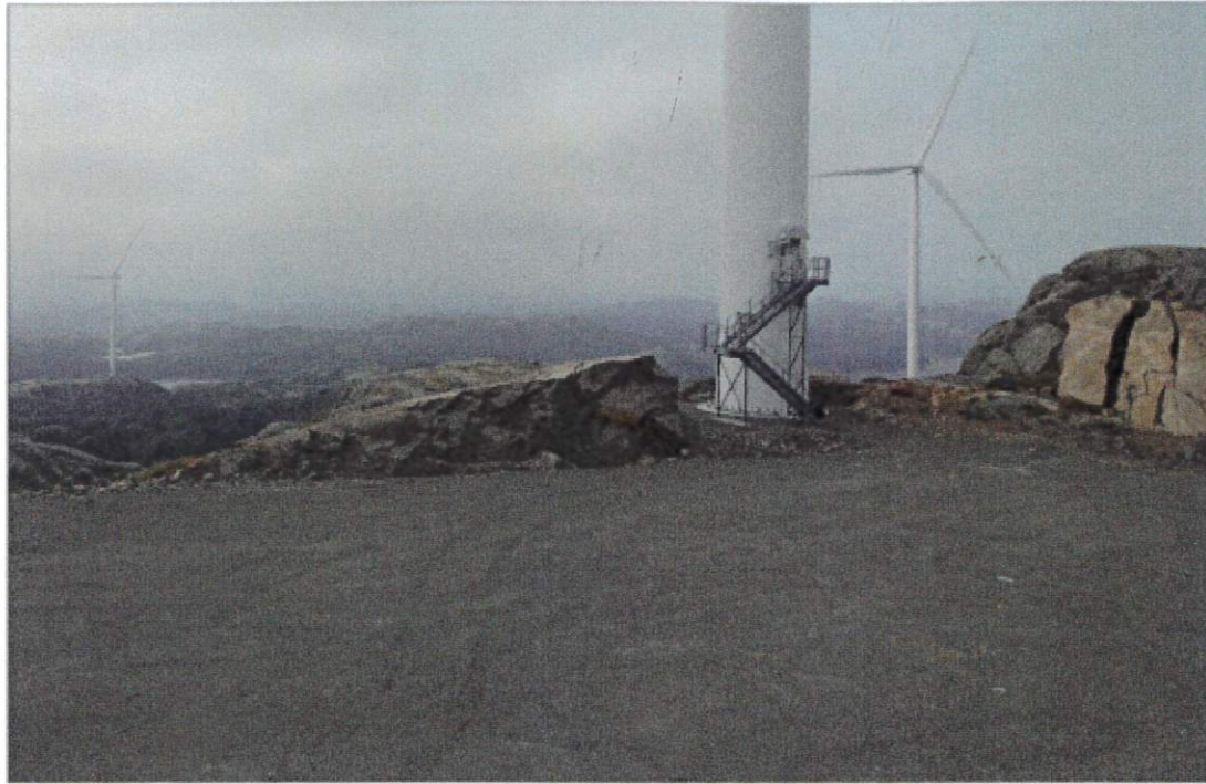
Oppstillingsplass. Fjelltoppen er sprengt flat. Legg merke til sykkelen ved trappen. Foto: Anne Katrine Lycke
