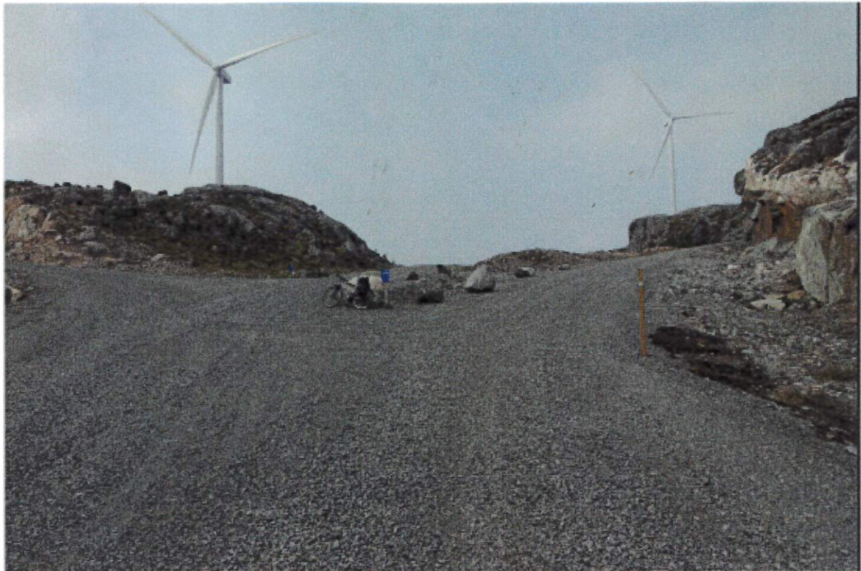
Egersund vindpark. Veikryss ca. 40 meter bredt. Foto: Anne Katrine Lycke
