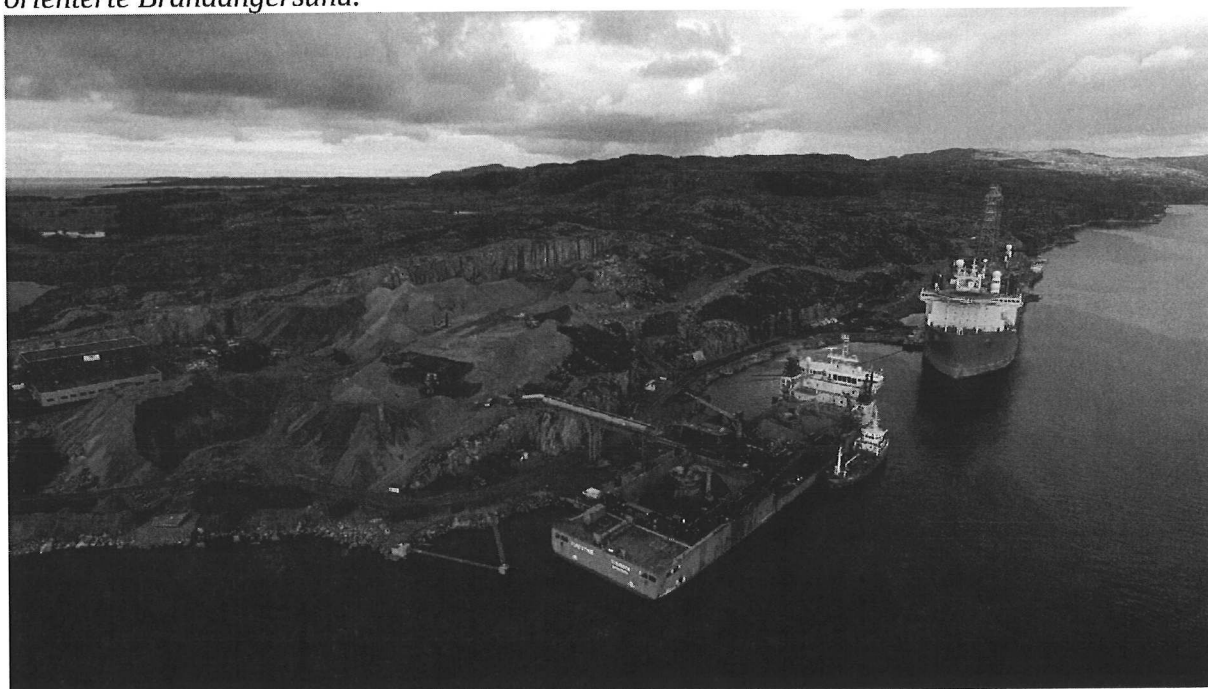
Fig.3: Flyfoto/dronefoto viser Skipavika Næringspark i en tidlig fase. Langsmed land er det montert pullerter. Fjellet er sprengt og knuses ned til pukkformat til offshoreformål. Samtidig er det til venstre etablert næringsbygg, der knust fjell er fjernet. Conwayer belte er montert for lasting av skip. Foto: Hans Harald W. Hellandsjø.
