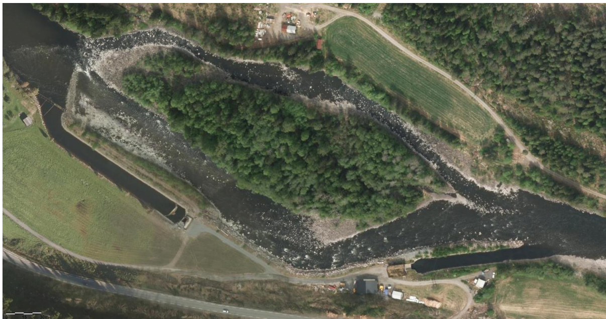
Figur 5 - Flyfoto fra norgebilder.no . Koparvike kraftverk, Begna, Sør-Aurdal kommune
