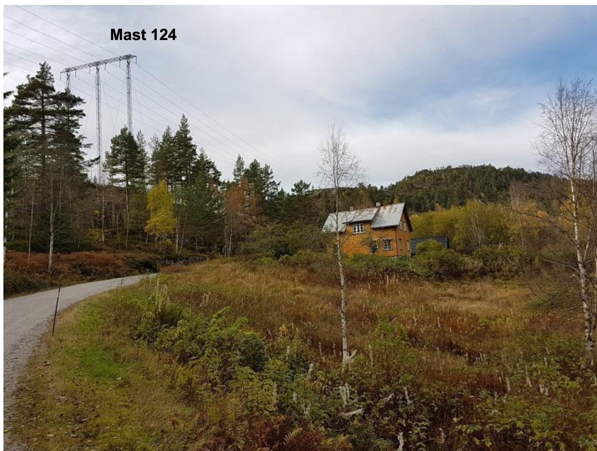
Figur 3-2 «132kV ledningen Brokkeledningene». Bildet er tatt fra Kleppeveien retning sørvest og viser boligen Torsbulia (48/19). Tiltaksområdet ligger til venstre og utenfor bildet. Det gule huset er ikke fast bebodd og brukes som fritidsbolig.
