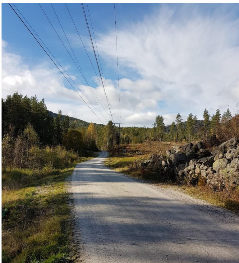
Figur 8-3. Bildet viser eksisterende 22 kV ledninger som vil rives ved etablering av Tørdal transformatorstasjon. Ledningene krysser her Kleppveien ved Røland.
