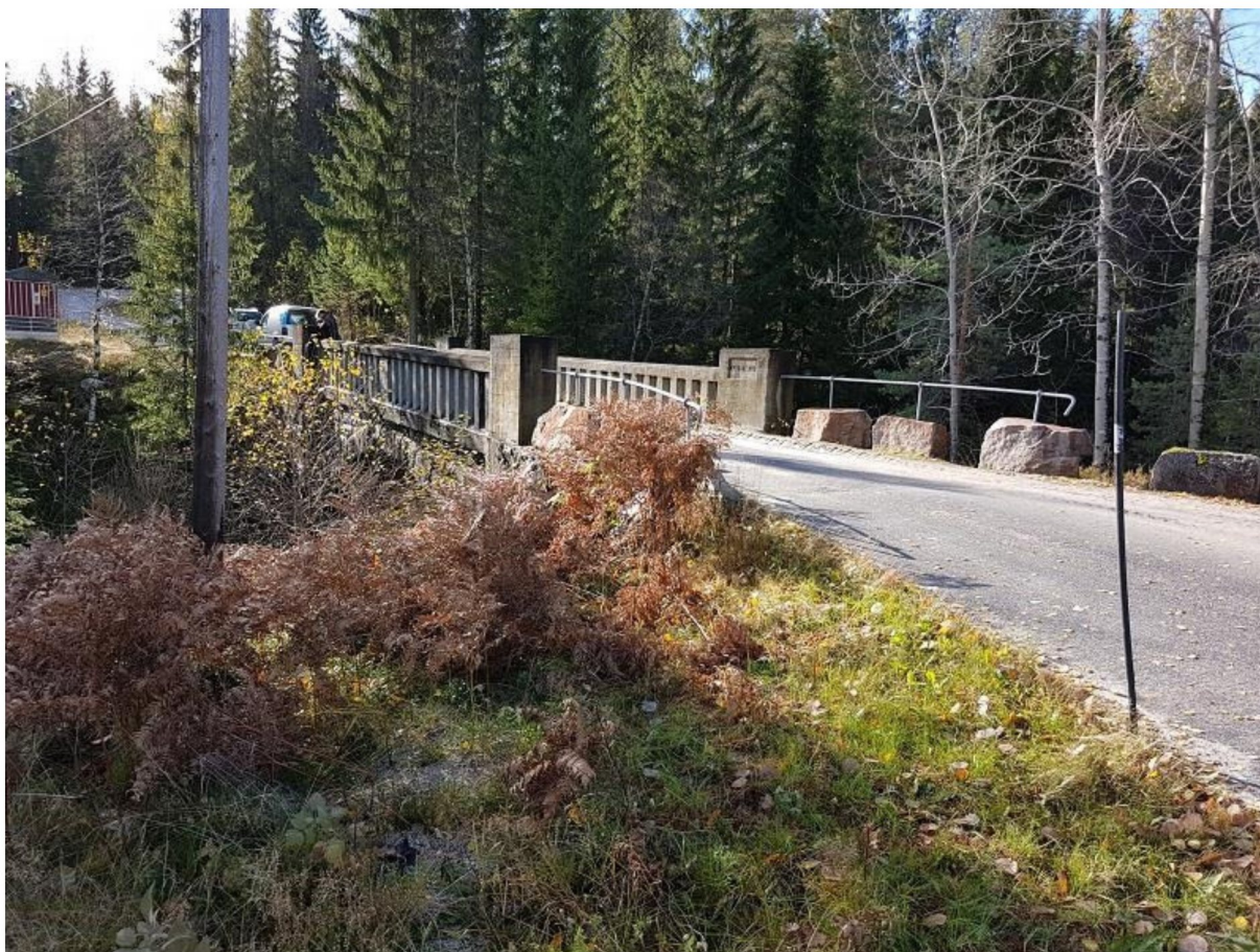
Figur 8-5 Krokane bru over Suvdøla.
