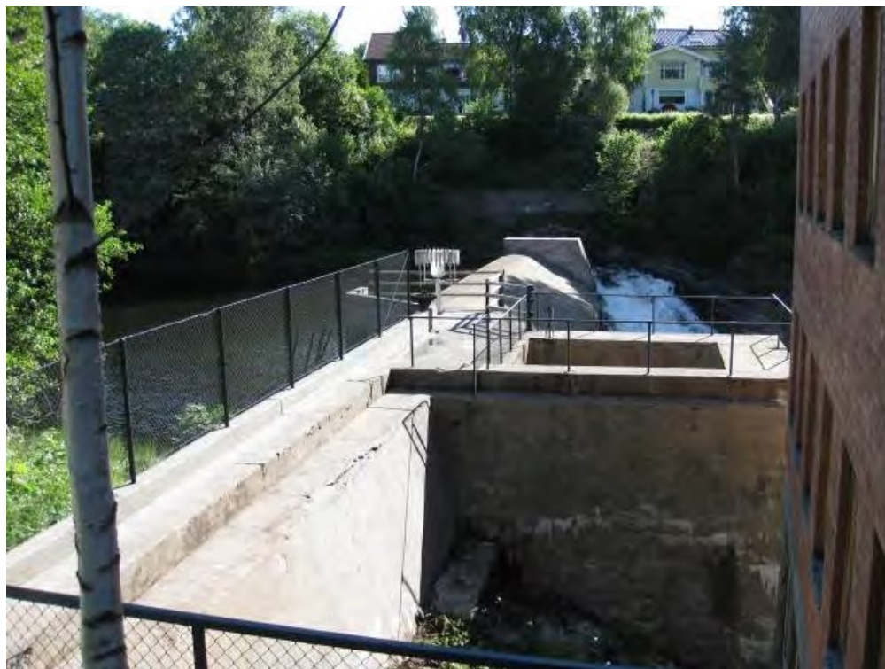
Bilde 3 - Oversikt massivdam ved høyre vederlag
