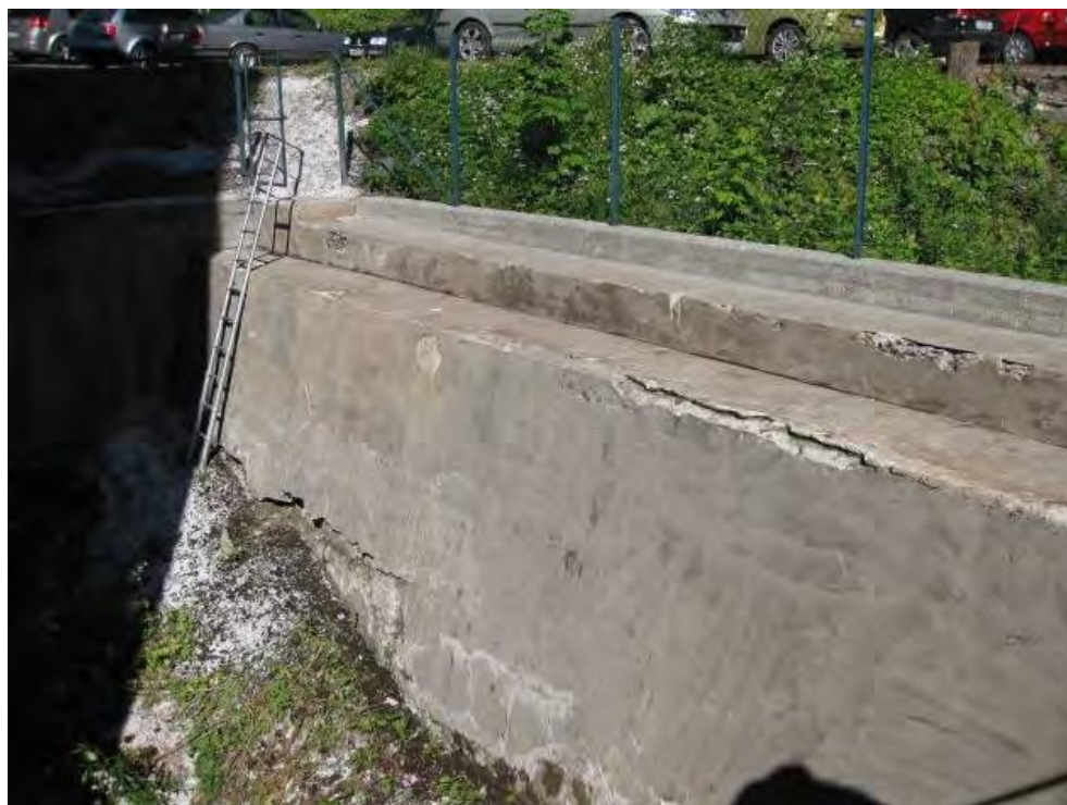
Bilde 4 - Luftside ved massiv betongdam
