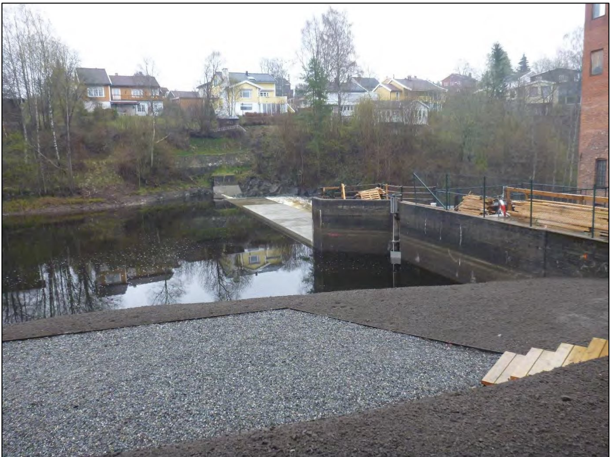
Bilde 3: Bilde tatt ved ferdigstilling av anleggsarbeidene 3. mai 2016. (Foto: Norconsult)
