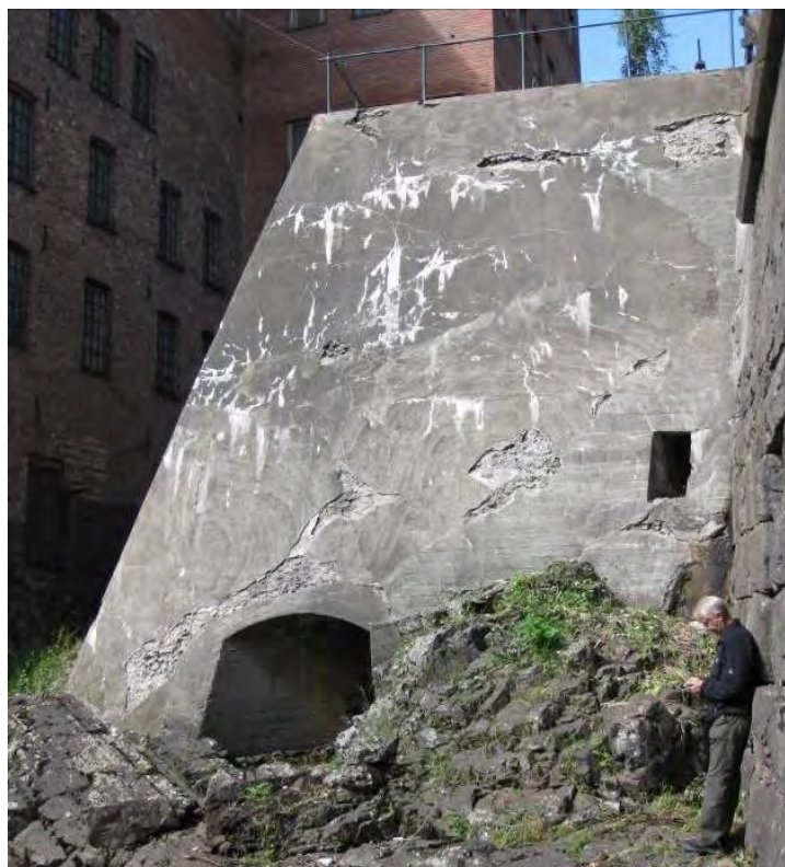
Bilde 8 - Gammel inntakskonstruksjon. Utløp fra bunntappeluke nederst til venstre.
