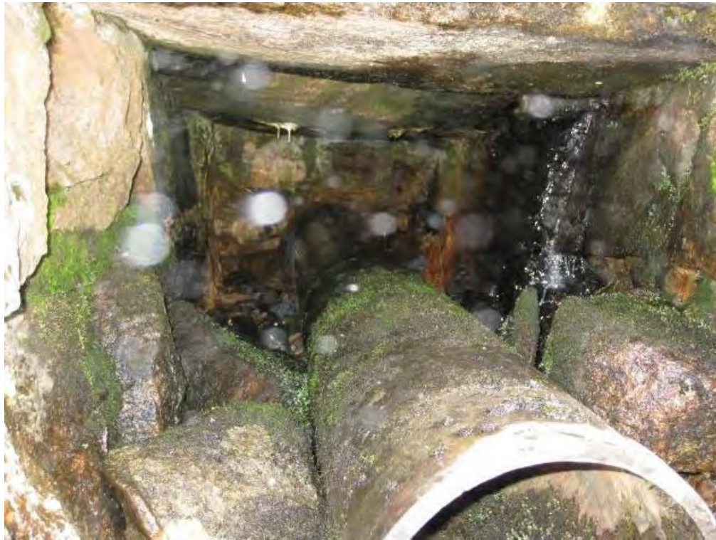
Bilde 7 - Gjenstøpt tappeløp mot høyre vedrelag
