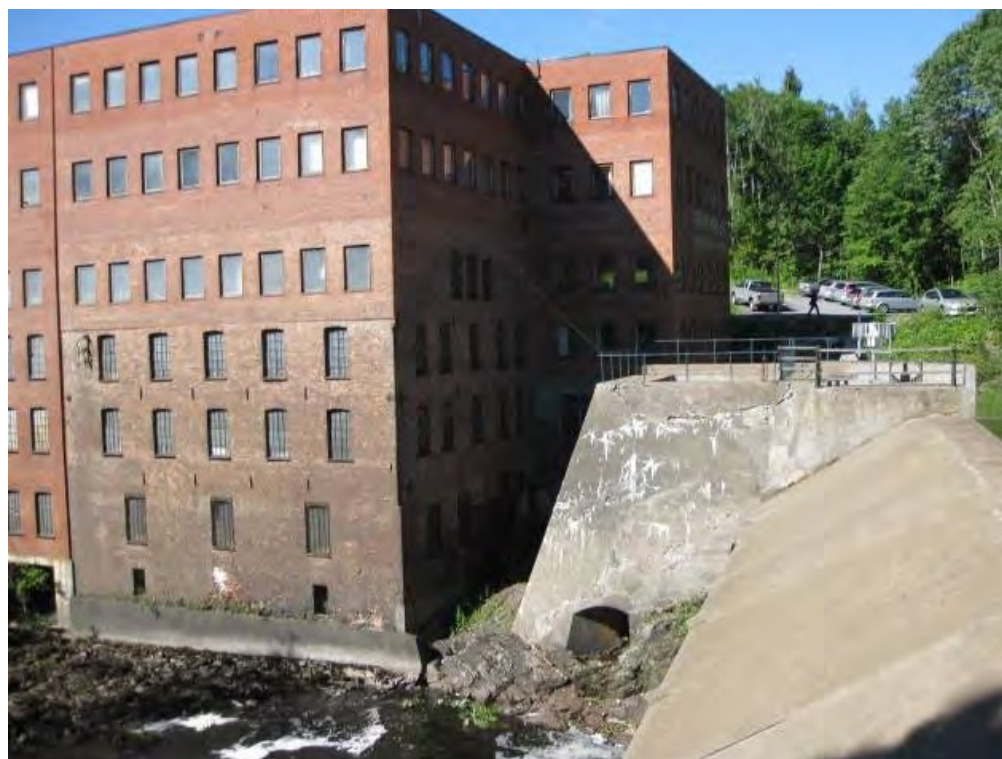
Bilde 2 - Oversikt flomløp mot høyre vederlag
