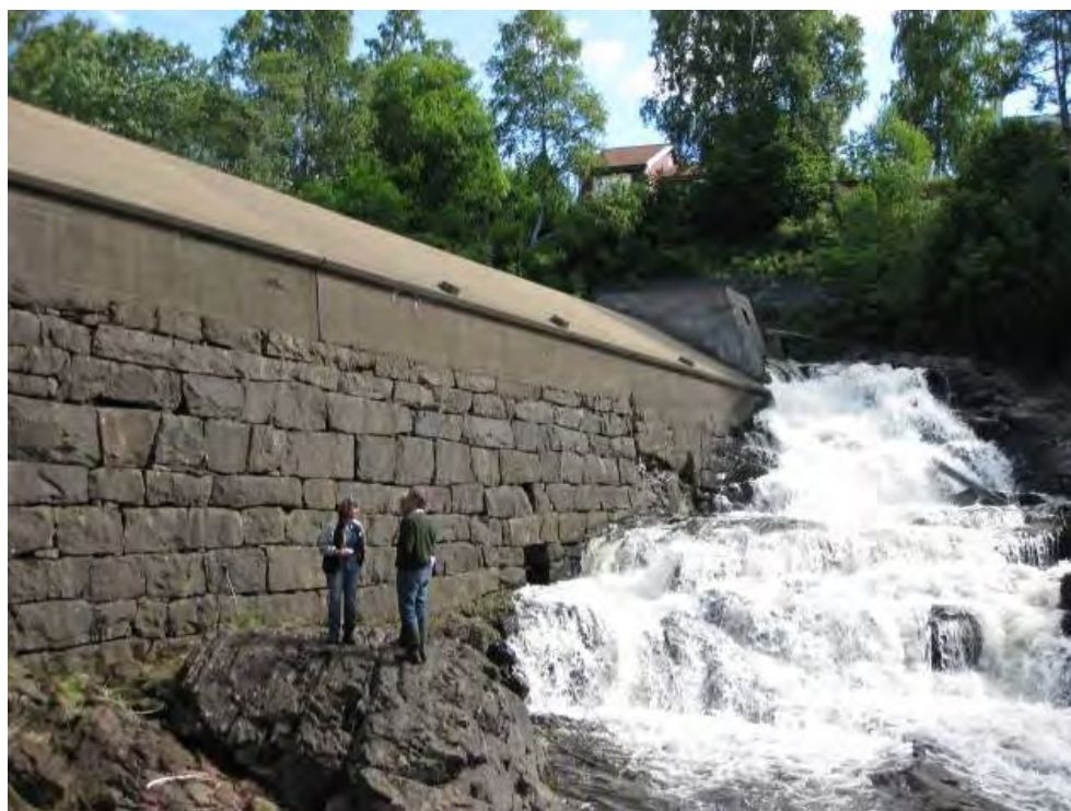
Bilde 6 - Luftside, flomløp. Gjenstøpt tappeløp synlig mot høyre vederlag
