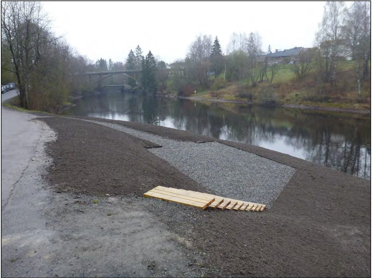
Bilde 2: Bilde tatt ved ferdigstilling av anleggsarbeidene 3. mai 2016. Strandsonen på motsatt side er eksponert som følge av vannstandssenkning. (Foto: Norconsult)
