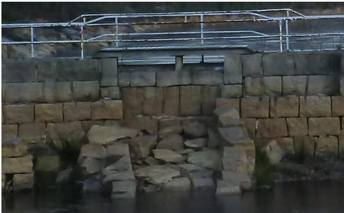
Bilde 1. Overløpet ved søndre murdam sett fra nedstrøms side, terskelen er planlagt senket med ca. 1 m.
