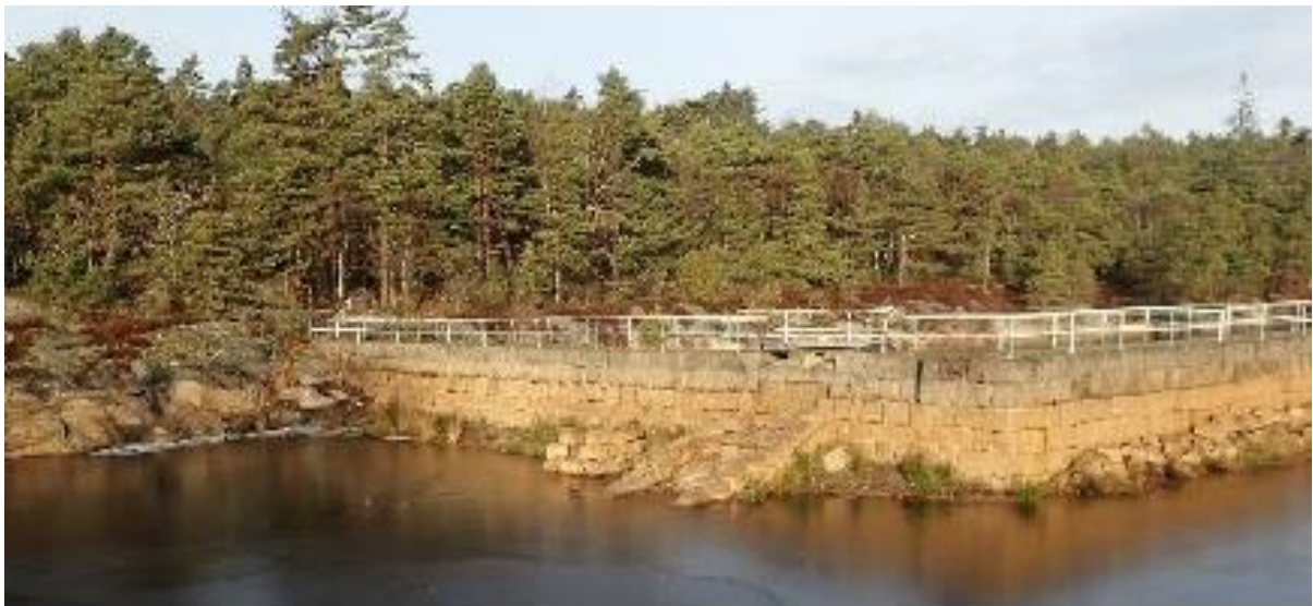
Figur 3: Dagens overløp ved Trondalsdammen sett fra nedstrøms side av søndre murdam.
