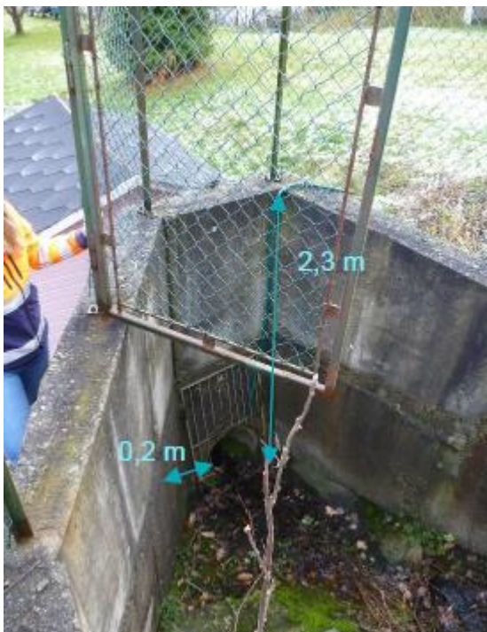
Figur 5: Her føres overløpet fra platedammen inn i nedgravd rør, ca. 20 meter nedstrøms overløpet. Rørdiameter er 450 mm.
