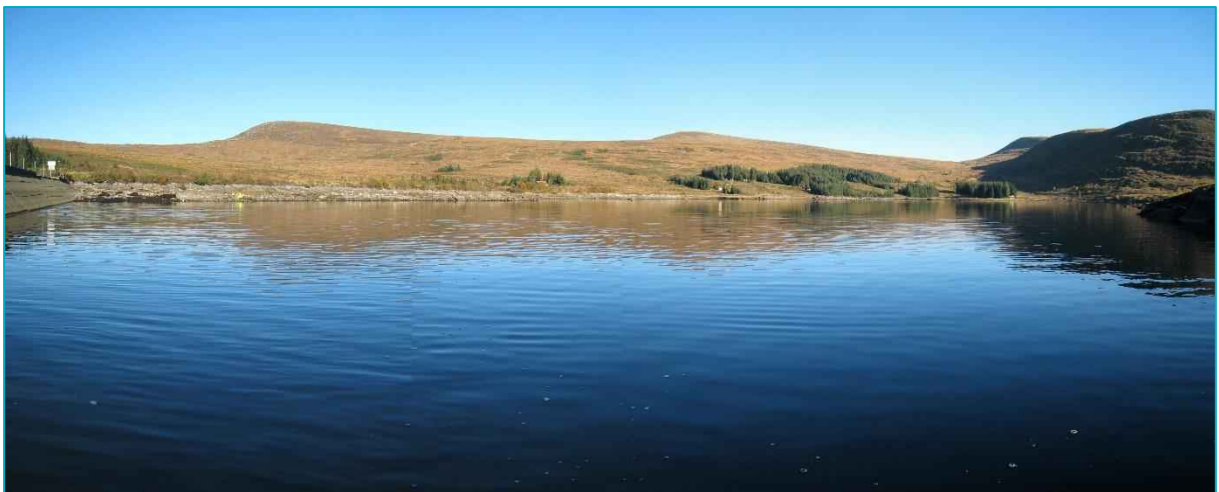
Figur 26. Fyllingsdamsanslutningen sett fra sør.
