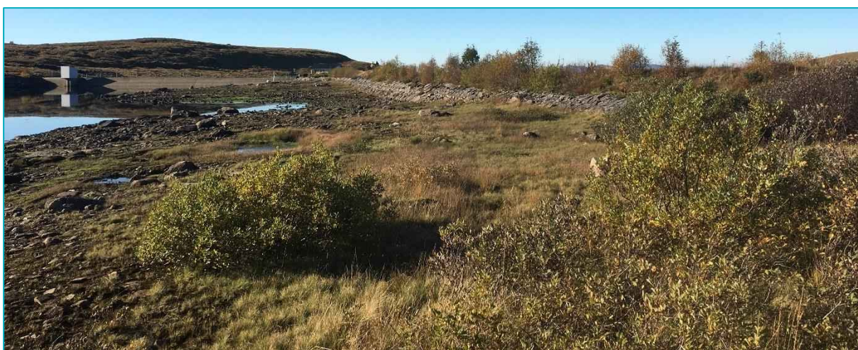
Figur 24. Oppstrøms for fyllingsdamsanslutningen, sett fra øst.
