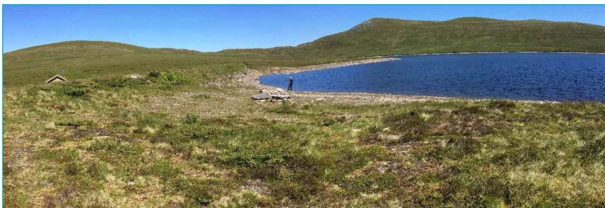
Figur 19. Oversiktsbilde oppstrøms side og magasin.
