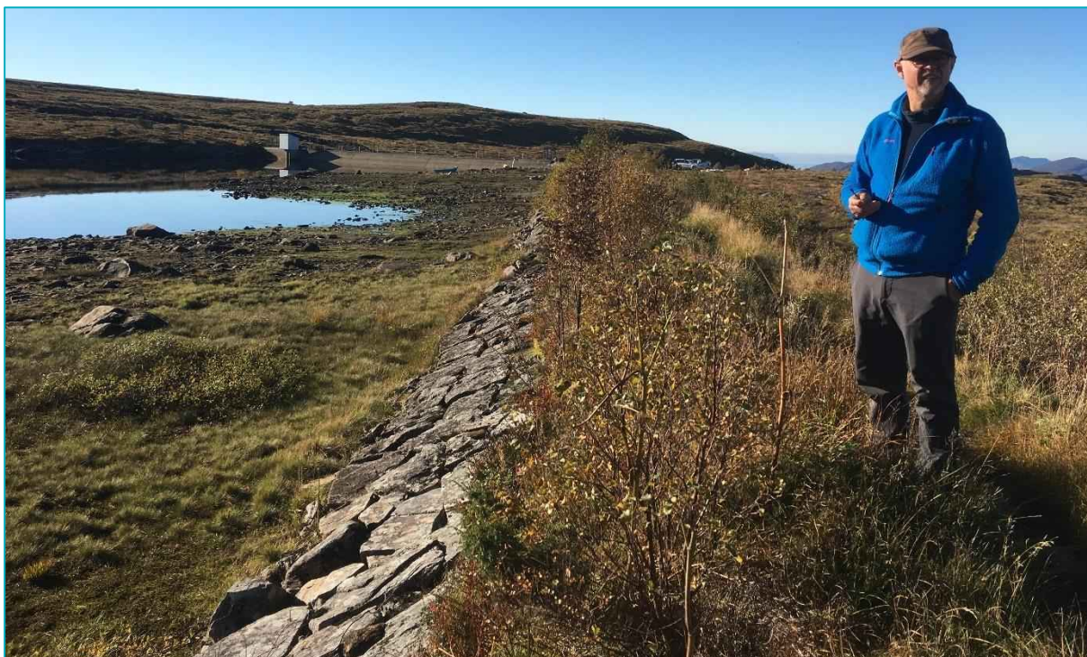
Figur 12. Fyllingsdam Litlevatn, med platedammen i bakgrunnen.
