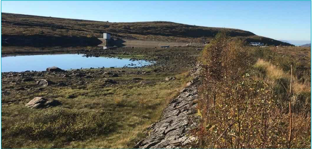
Figur 25. Damkrone og området oppstrøms for fyllingsdamsanslutning og platedam.
