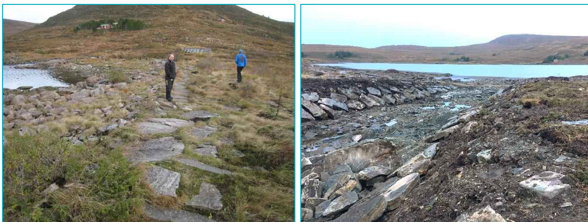
Figur 13. Overløp i magasinets sør-ende før (t.v.) og etter (t.h.) ombygging i 2016.
