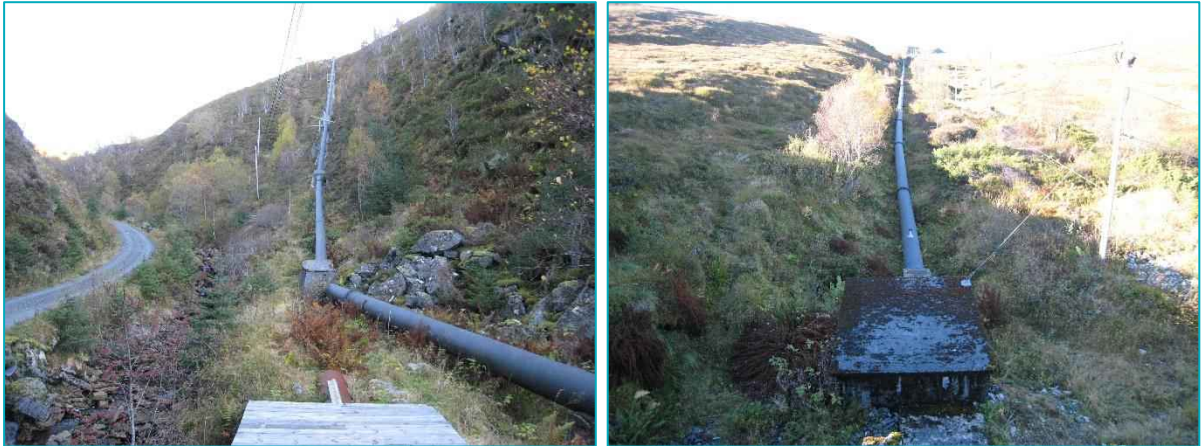
Figur 16. Rørgaten sett fra adkomstveien, like oppstrøms for kraftverket (t.v.) og fra inntaket på dammen (t.h.).
