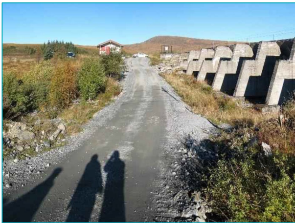
Figur 29. Midlertidig adkomstvei nedstrøms dam Litlevatn.
