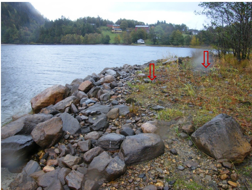
Figur 14. Bilde tatt den 22. okt. Raude piler viser omtrent kor sprekken går i terrenget. Det gjekk eit skred i område er like til høgre for øvre bildekant. Det losna når vatnet steg raskt på grunn av mykje nedbør etter å ha vore nedtappa (sjå. fig. 10, 11 og 12).
