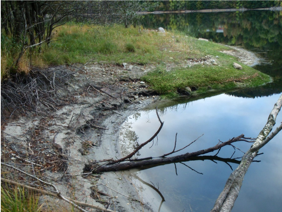
Figur 11. Tidlegare skredkant som vatnet til tidar eroderer i. (FOTO: Britt Eide, 12. okt.). Skredhendinga skal ha skjedd i nov/des. 1993.
