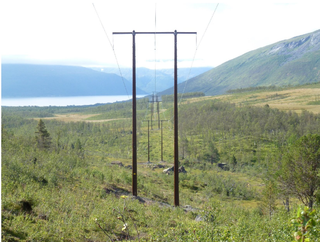
Figur 5-14 Eksempel på komposittmast med planoppheng.
