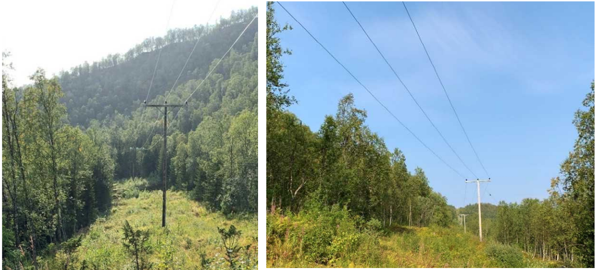
Figur 4-17 Eksisterende 22kV linje langs Lysvatnet. Stedvis meget sidebratt terreng kan gi utfordringer, jf. bildet til venstre.
