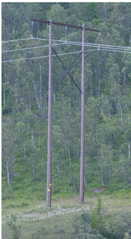
Figur 2-1 H-master i komposittmateriale med og uten avstivende kryss. Faseavstanden vil være 5 meter, slik at total bredde mellom ytterfaser er 10 meter. Høyder vil typisk være i intervallet 15-20 meter.
