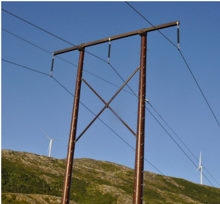
Figur 6-1. Komposittmastene som er etablert på Kvaløya. Gjenskinn i mastene er påfallende ved solskinn. Den mørke fargen kunne vært noe dempet for å redusere kontrasten mot bakgrunnen.
