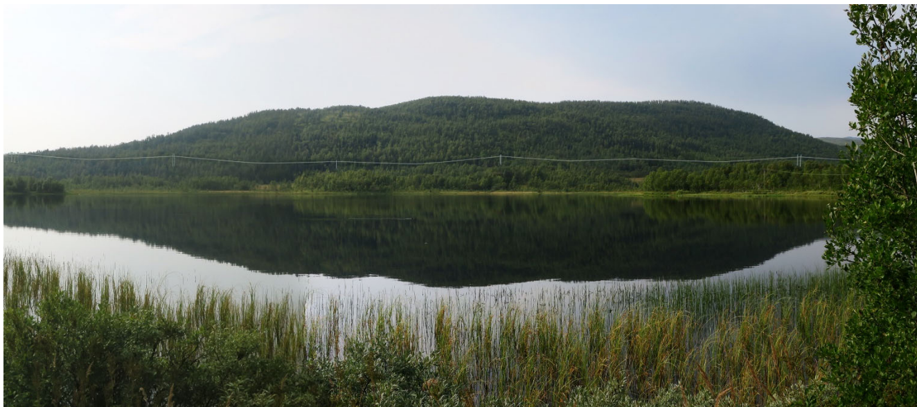
Figur 5-19. Visualisering av kraftlinje sett fra Fv. 861 over Jøtulvatnet til foten av Kvannåslia. Av visualiseringen ser man at linja vil absorberes godt av skog. Avhengig av årstid og betraktningsspunkt vil ryddegater i noen tilfeller være synlig fra bebyggelse. Dette gjelder i større grad på vinteren enn sommerstid.
