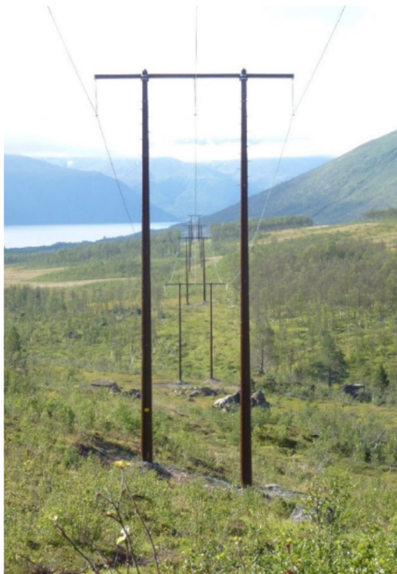
Figur 2-1 H-master i komposittmateriale med og uten avstivende kryss. Faseavstanden vil være 5 meter, slik at total bredde mellom ytterfaser er 10 meter. Høyder vil typisk være i intervallet 15-20 meter.
