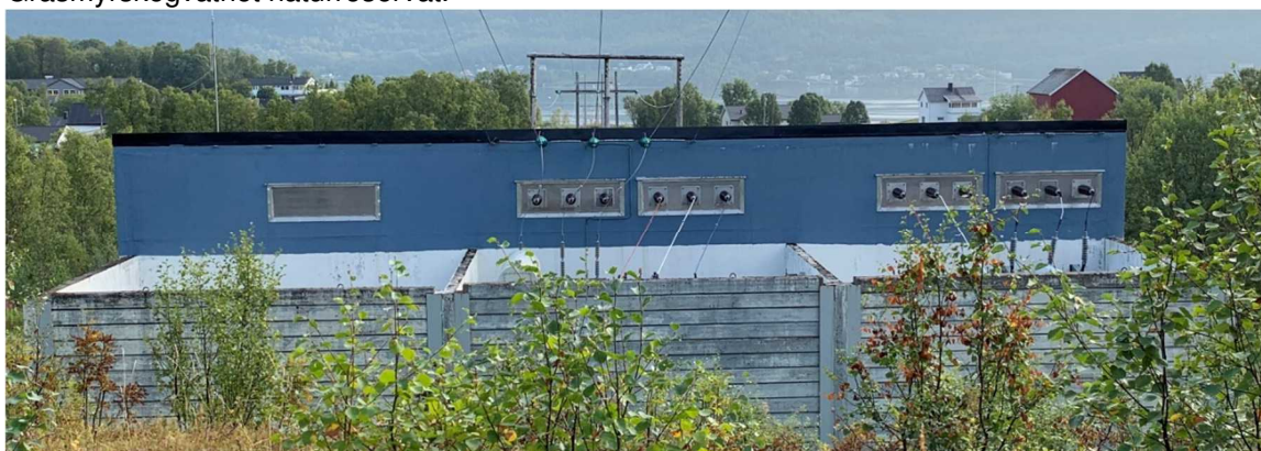
Figur 2-10 Silsand transformatorstasjon. Ny linje vil gå ut mot venstre i bildet.
