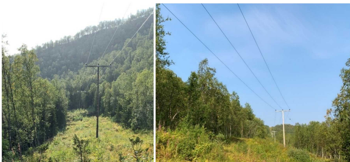
Figur 2-19 Eksisterende 22kV linje langs Lysvatnet. Stedvis meget sidebratt terreng kan gi utfordringer, jf. bildet til venstre
