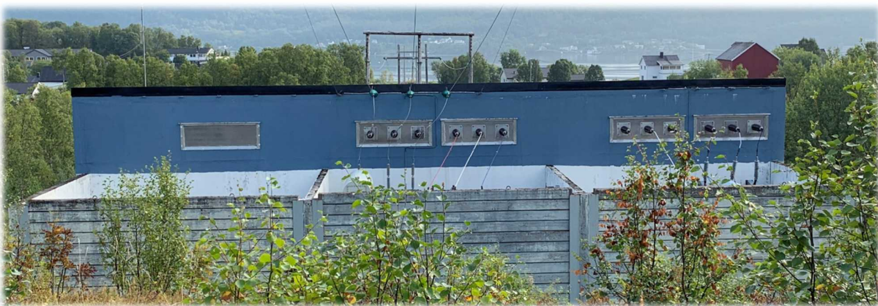
Figur 2-9 Silsand transformatorstasjon. Stasjonen vil utvides utvides mot venstre i bildet, og ny ledning vil komme inn som jordkabel.
