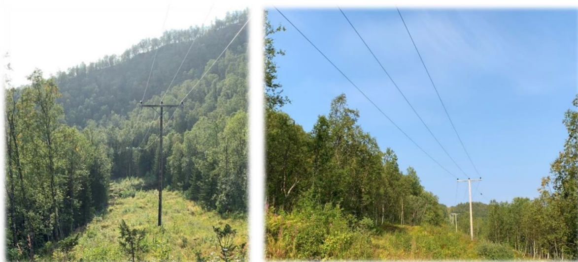
Figur 2-16 Eksisterende 22kV linje langs Lysvatnet. Stedvis meget sidebratt terreng kan gi utfordringer, jf. bildet til venstre.
