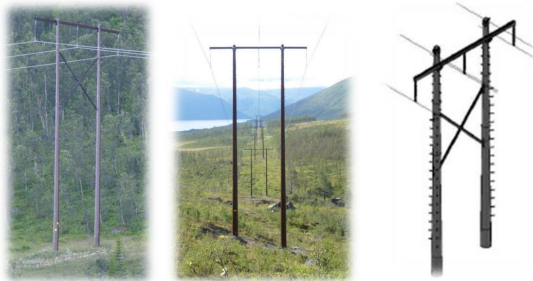
Figur 2-1 H-master i komposittmateriale med og uten avstivende kryss. Faseavstanden vil være 5 meter, slik at total bredde mellom ytterfaser er 10 meter. Høyder vil typisk være i intervallet 15-20 meter. Mast med overliggende jordledere vist lengst til høyre.
