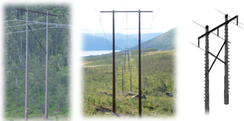
Figur 3-2 H-master i komposittmateriale med og uten avstivende kryss. Faseavstanden vil være 5 meter, slik at total bredde mellom ytterfaser er 10 meter. Høyder vil typisk være i intervallet 15-20 meter.
