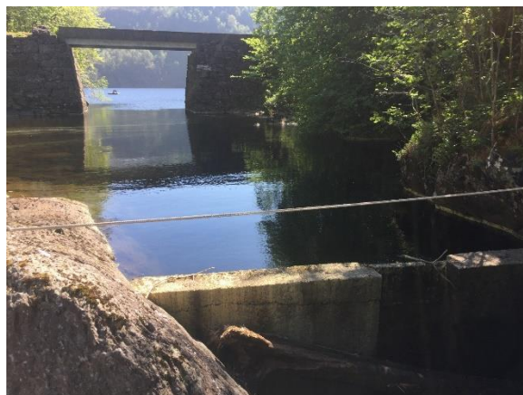
Bilde 3. Botsvatnet, 24.05.2018. Betongstemme i enden av Botsvatnet. Naturlig terskel under bro.
