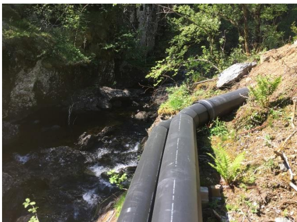
Bilde 3. Rørtrasè. 24.05.2018. Her går rørene inn under vei mot foss.
