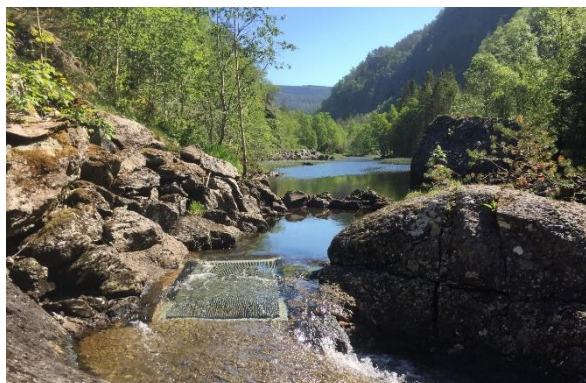
Bilde 4. Utlebøen, 24.05.2018. Inntak 2, 450 mm rør (hovedinntak).
