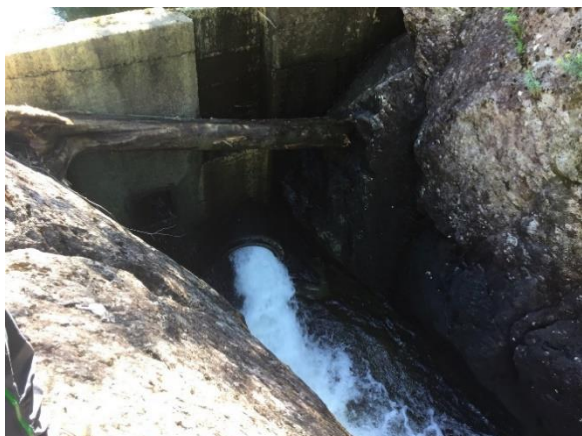
Bilde 2. Botsvatnet, 24.05.2018. Betongstemme med dykket ventil DN 600 mm oppstrøms betongstemme og plankestengsel.
