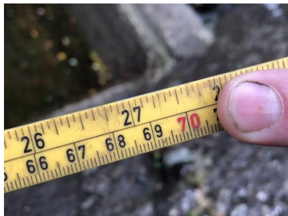
Bilde 2. Botsvatnet, 31.07.2018. Nivå i Botsvatnet målt til -71 cm fra terskel på betongstemme. 4-5 ganger på 30 år med drift har det vært målt nivå ned mot -100cm.
