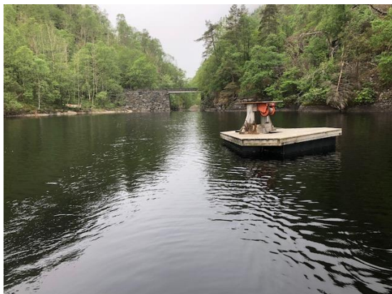
Bilde 1. Botsvatnet, 24.05.2018. Inntak 1, 355 mm (under flåte). Kan regulere dybdenivå med vinsj.
