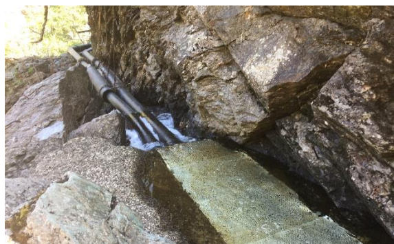
Bilde 5. Femanger, 24.05.2018. Inntak 3 ved foss. 2x250 mm rør som går over til 400 mm rett nedenfor.
