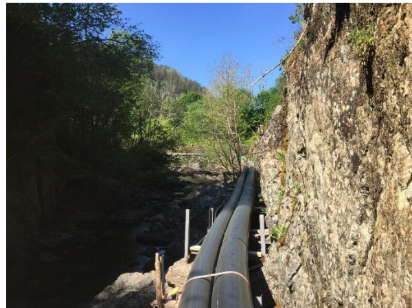
Bilde 2. Rørtrasè, 24.05.2018. Rør i dagen, nedstrøms inntak 2.
