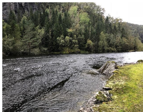
Bilde 10. Oppstrøms inntak 2, 24.09.2018. Høy vannføring.
