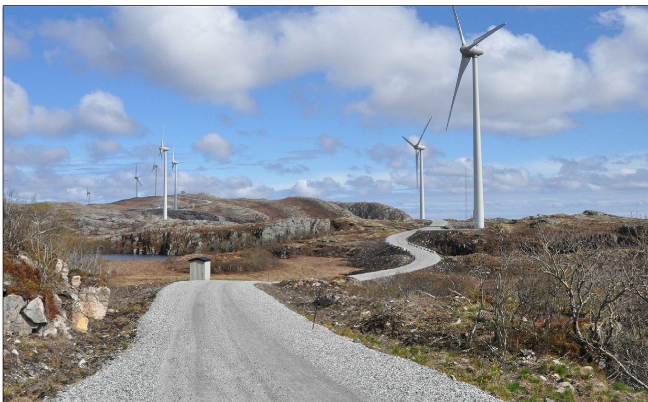
Figur 13. I det småkuperte landskapet er økt veglengde å foretrekke foran skjæringer. I tillegg kan traseen gjerne legges med litt høyde i terrenget, siden fyllinger lettere kan gis en naturlig tilpassing enn skjæringer.
