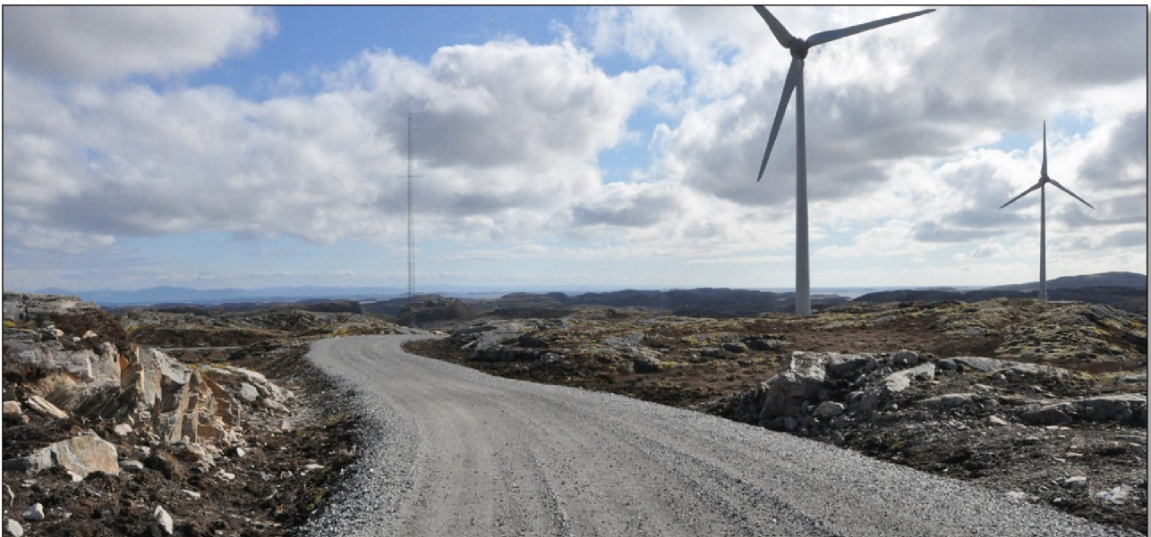
Figur 17. En mindre skjæring står igjen på venstre sida av vegen. Mindre pigging i toppen, som vist på manipulert bilde nederst, er alt som skal til for at oppstikkende nabber på begge sider av vegen skal bli mindre påfallende.
