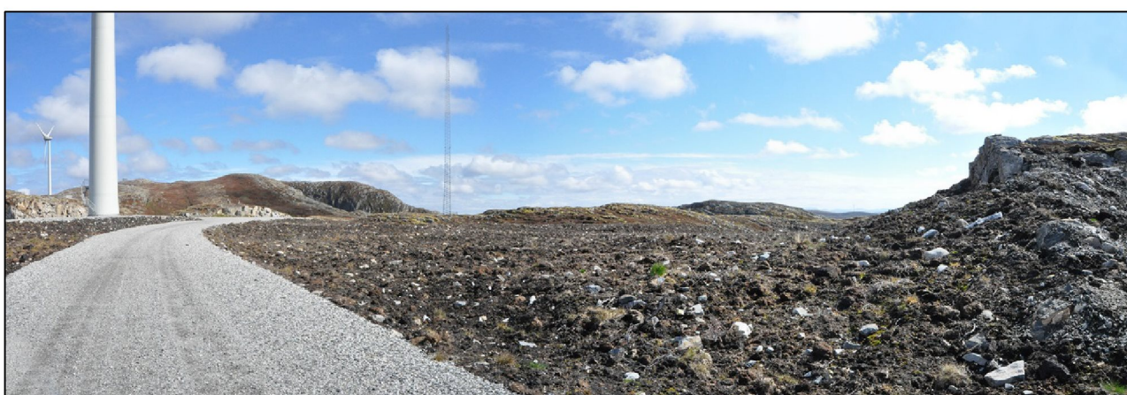
Figur 11. Istandsatt massetak har fått ei overflate som går fint til tiliggende terreng, men flata er noe stor og ensarta til at den visuelt aksepteres som en naturlig formasjon i det småkuperte terrenget.
