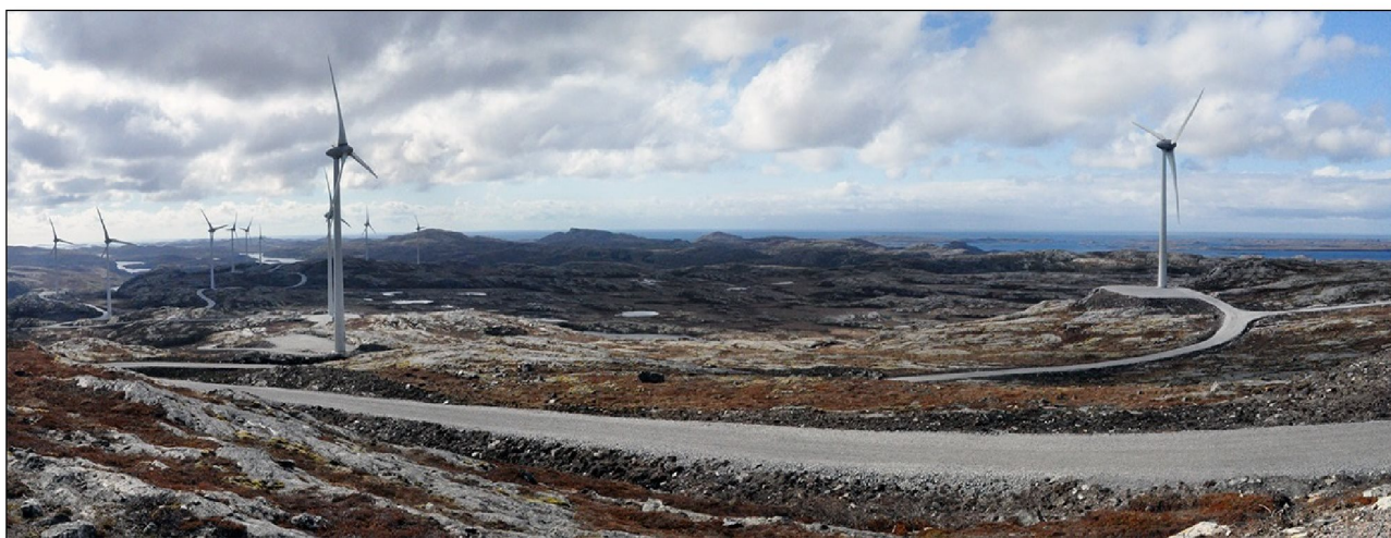
Figur 18. Panoramabildet viser kranoppstillingsplasser som generelt ligger godt i terrenget, med unntak av den ved vindturbinen til høyre i bildet som ligger noe høyt og blir dertil eksponert.
