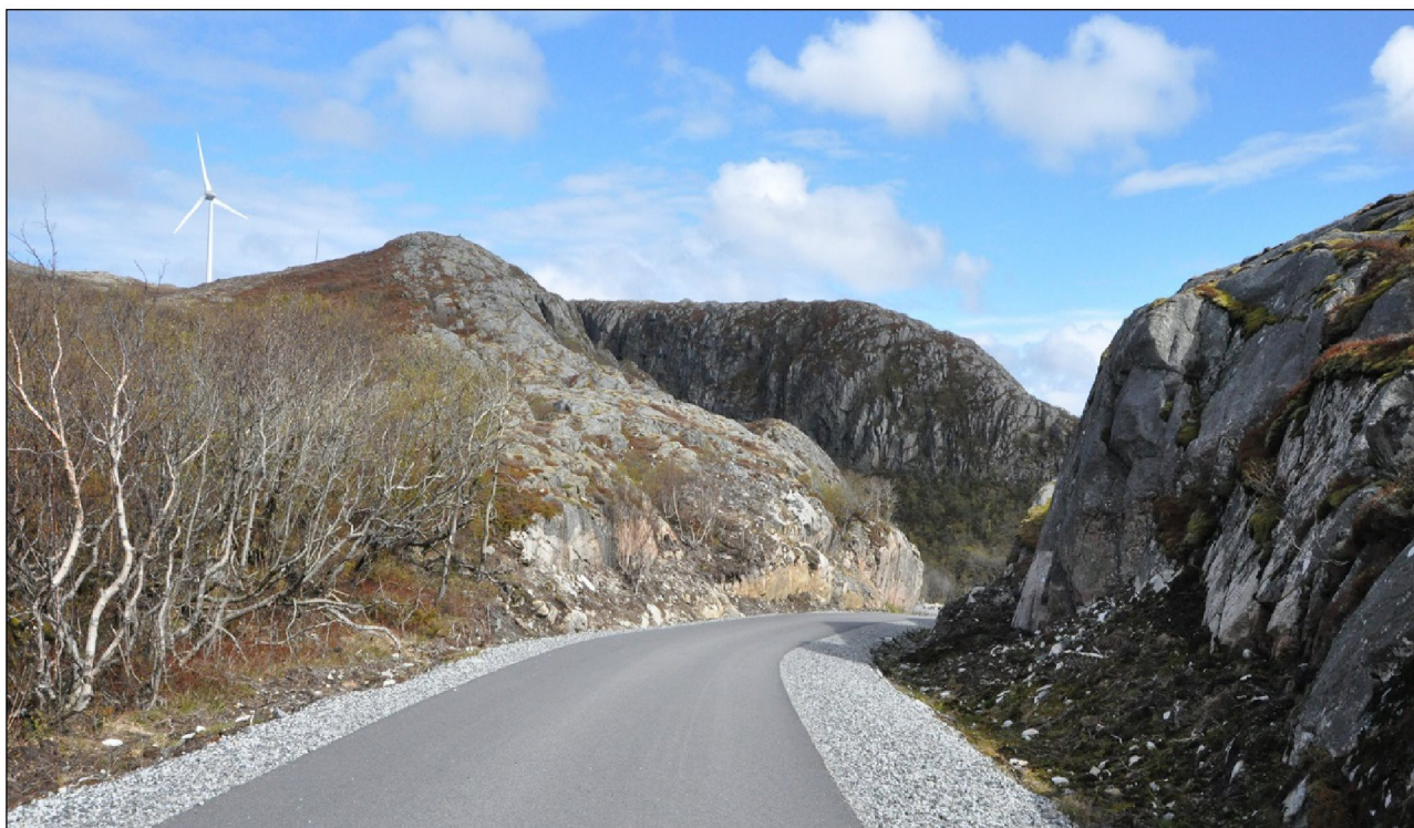
Figur 15. Dersom vegen må føres gjennom fjellparti og tosidige skjæringer ikke kan unngås, er det viktig at det settes av nok plass til at tverrsnittet føles romslig og skjæringene kan bearbejdes i bunn og topp for å minske deres visuelle høyde og myke opp profilet. (Originalbilde fra asfaltert adkomstveg til vindkraftverket på Ytre Vikna)
