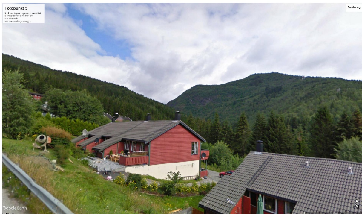
Figur 3-6. Fotopunkt som viser området der ledningen vil gå inn mot det eksisterende vannbehandlingsanlegget. Sett fra Kleppavegen mot nord. Kilde: Google Earth.
