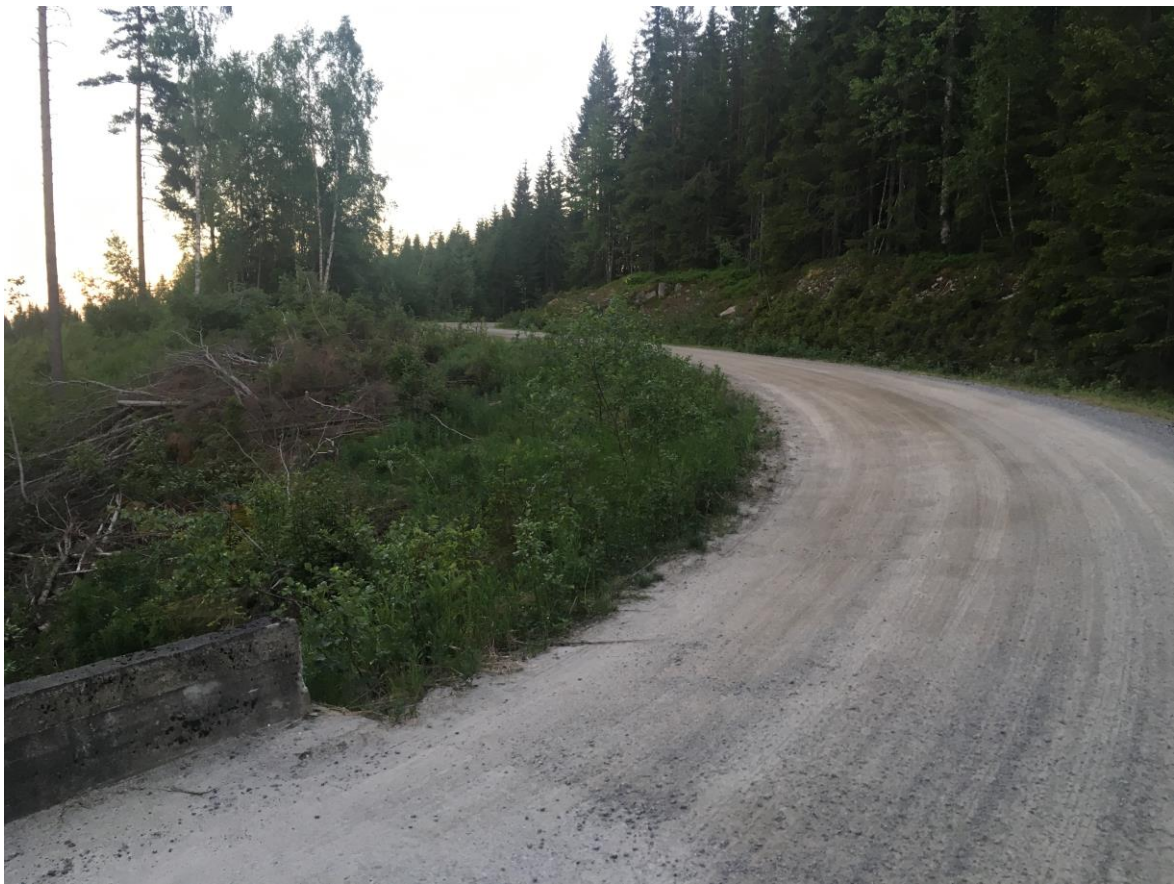
Bilde 3.1 Rør krysser skogsvei ved inntak ca kote 390 moh
