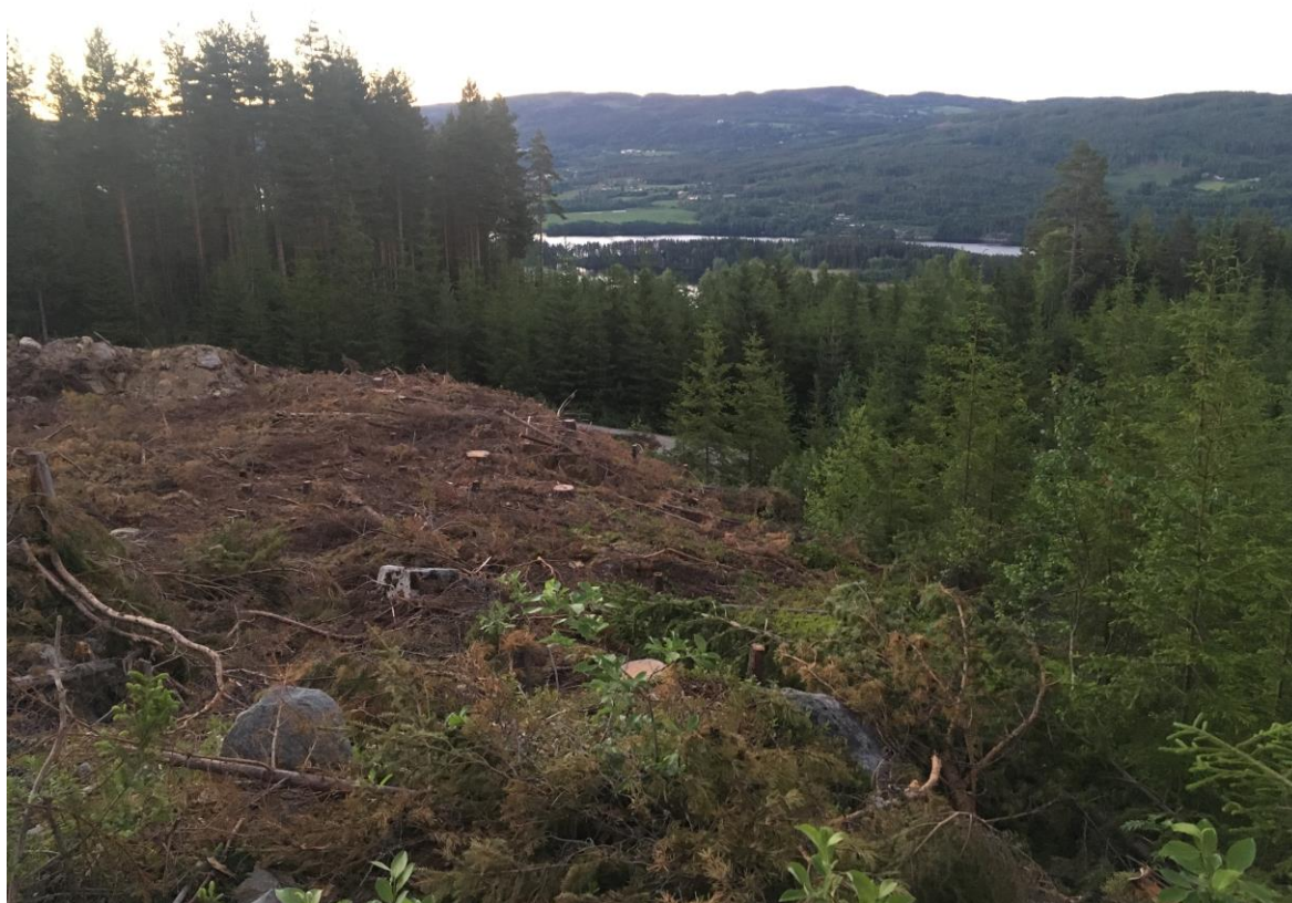
Bilde 3.3 Rør krysser skogsvei ved 2dre kryssing sett ned
