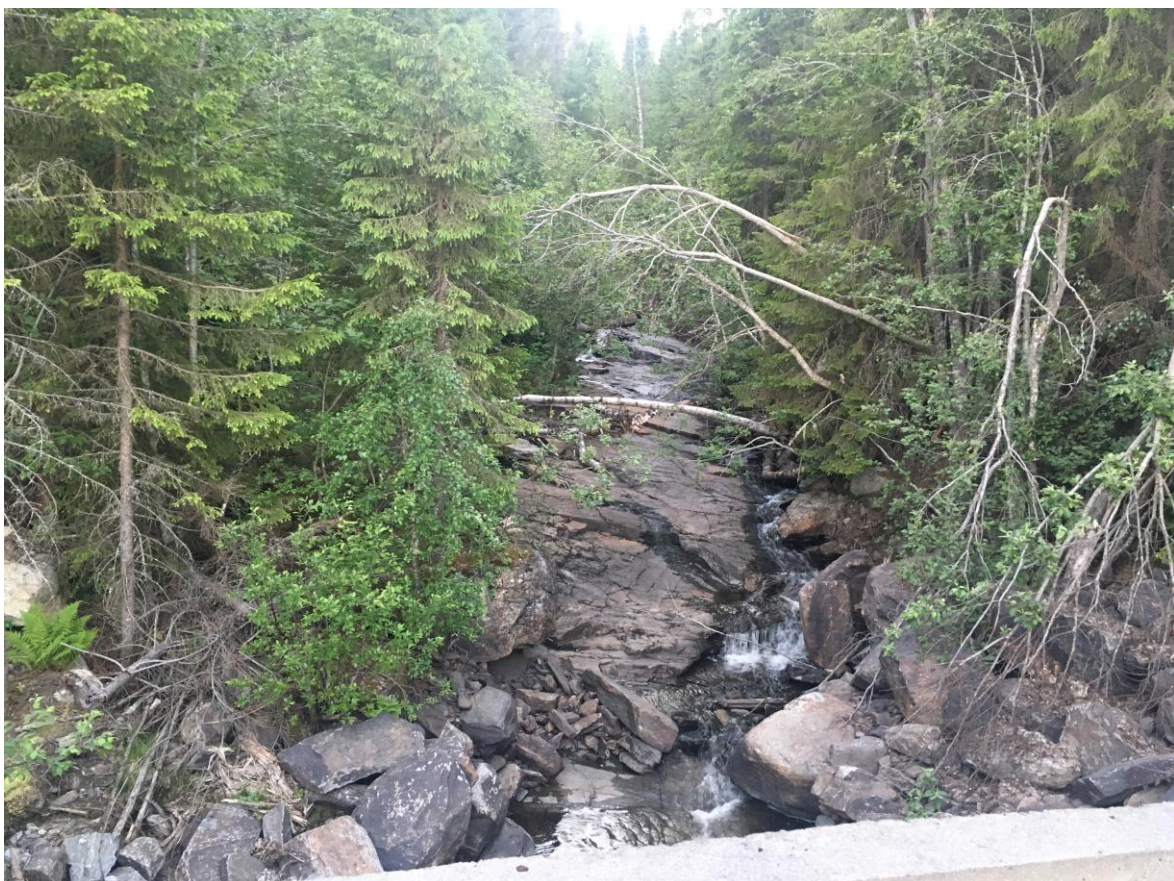
Bilde 2.2 Nytt Inntak fra bru og opp mot kote 395 moh
