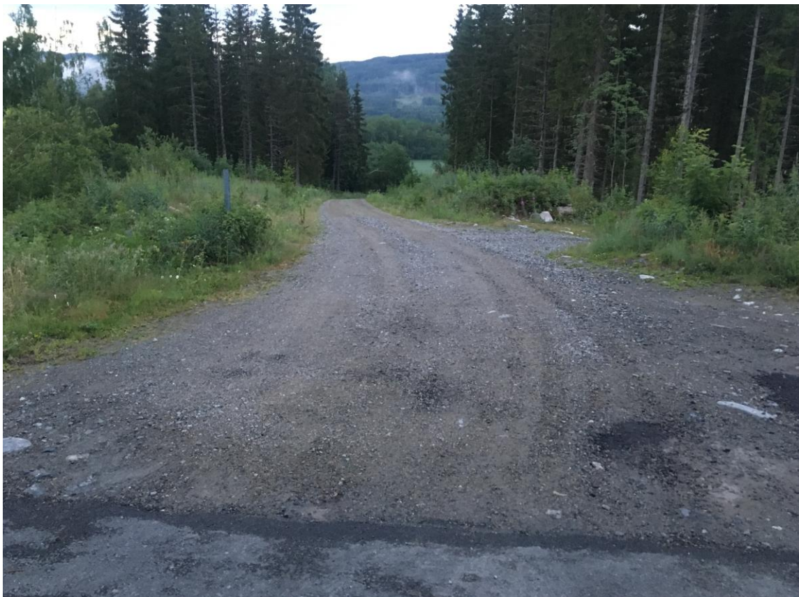
Bilde 1.2 Eksisterende vei opp til dam og inntak
