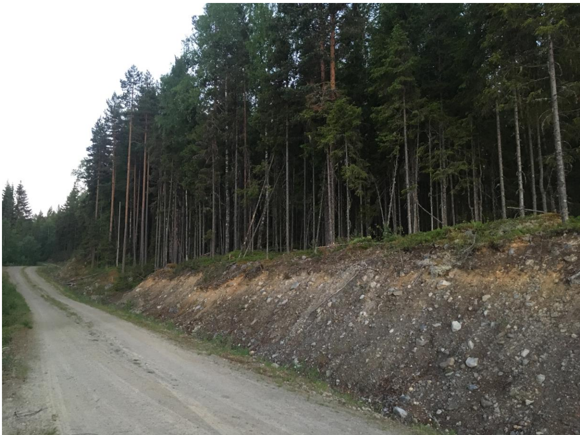
Bilde 3.2 Rørgate krysser vei 2 ganger ved 180 grader sving sett opp
