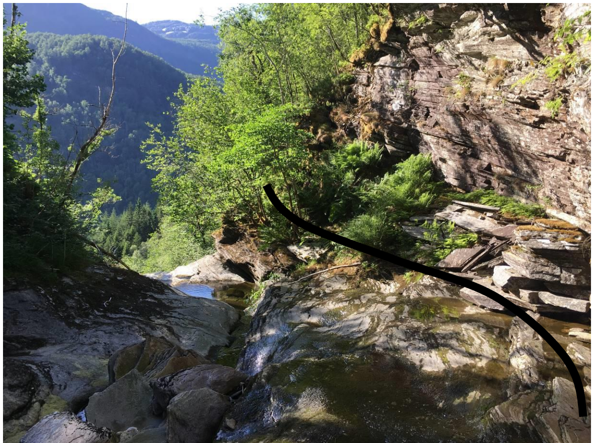
Bilde 4.1 Røtrase ut fra inntak lagt til høyre langs fjellet
