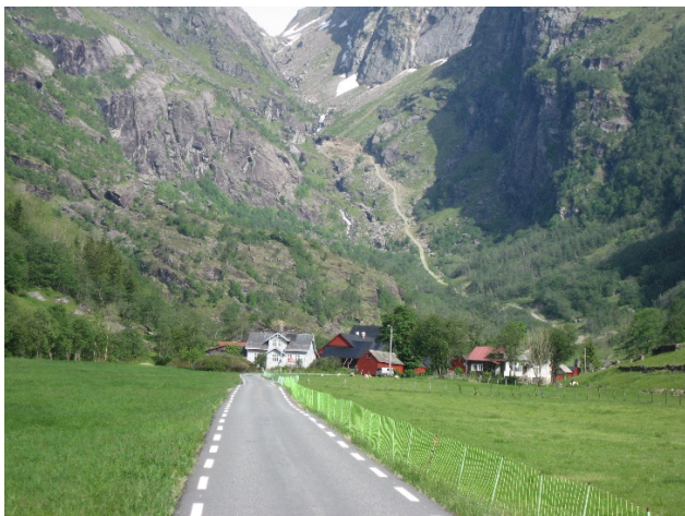
Øvre Hålandsdal, Fusa kommune, sett mot Tveitaskaret kraftverk og Eitro kraftverk
