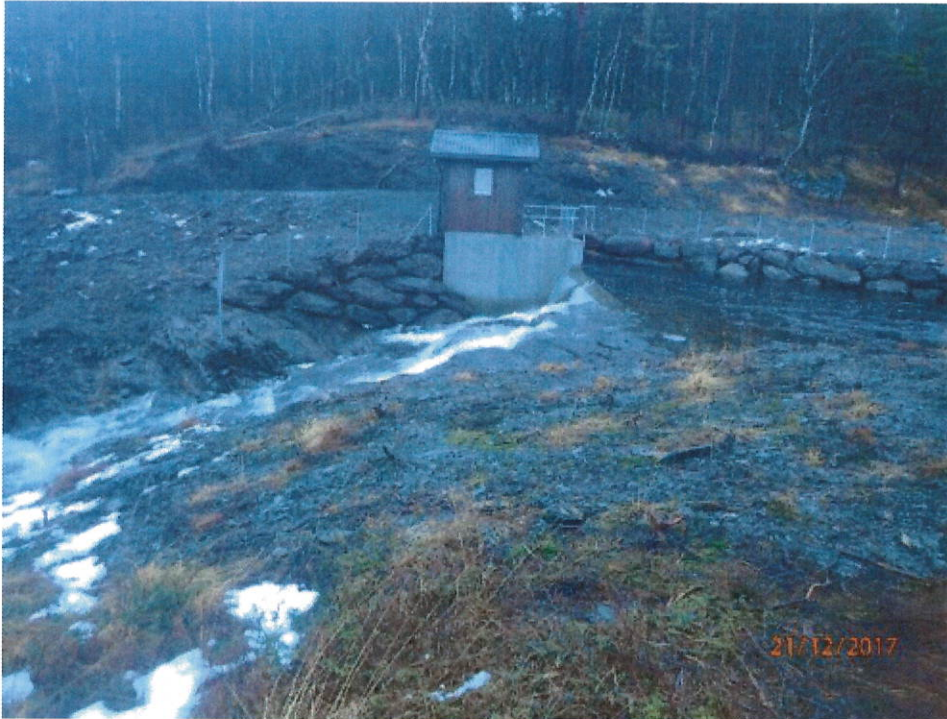
Bilde 7, tatt mot N, viser eksisterende dam, inntak, anleggsvei og riggområde
