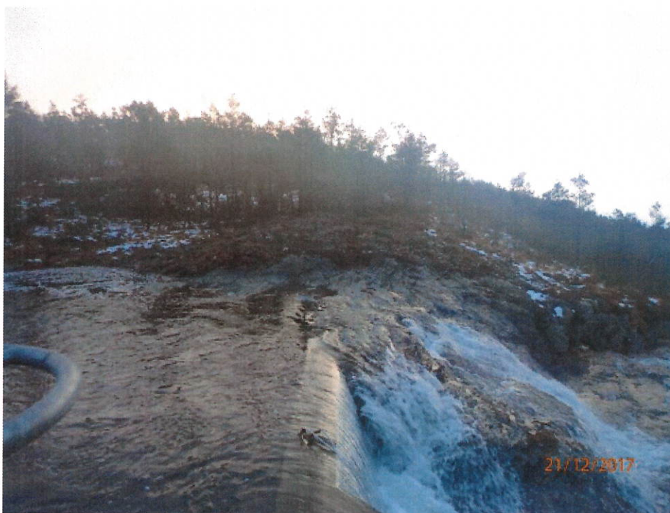
Bilde 2, tatt mot S, viser overløpsterskel i flomløpet
