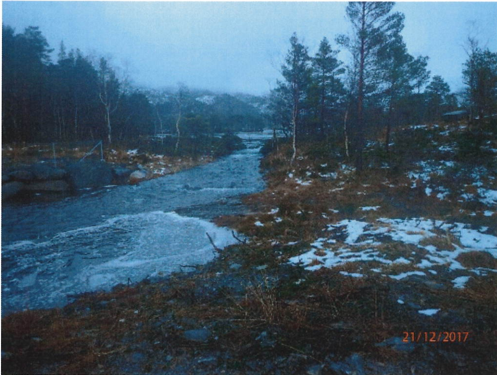
Bilde 11, tatt mot Ø, viser bekken fra Vikastølvatnet og området der en må sprengne ut ny kanal
