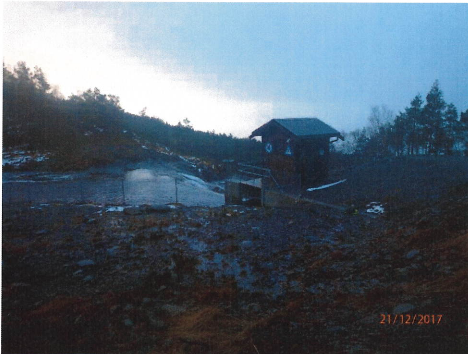
Bilde 3, tatt mot SV, viser dam, inntak og lukehus, som riggområde brukes arealet rett foran
