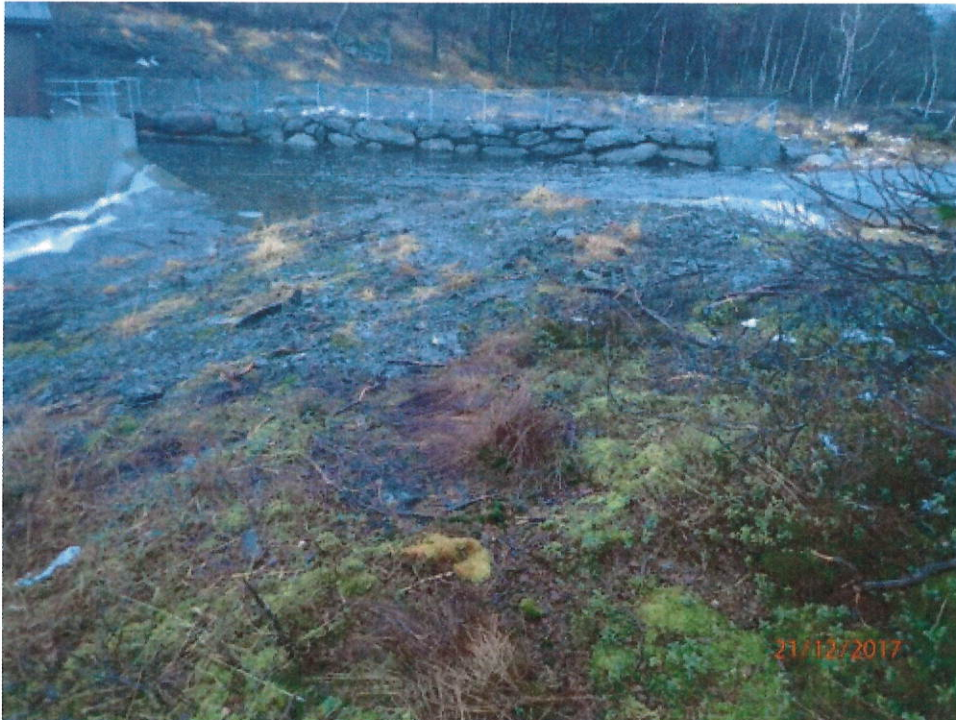
Bilde 9, tatt mot NNØ, viser område der ny dam kommer, tynt vegetasjonslag oppe på fjellet
