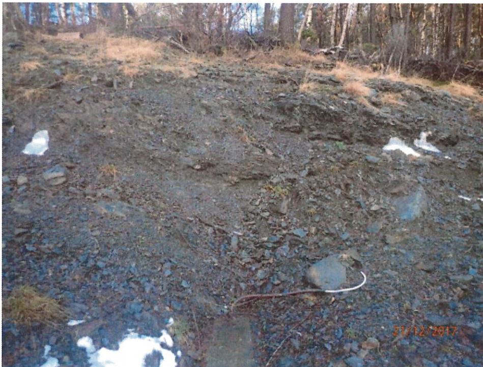
Bilde 6, tatt mot N, viser topp eksisterende dam høyre vederlag som ender i berg
