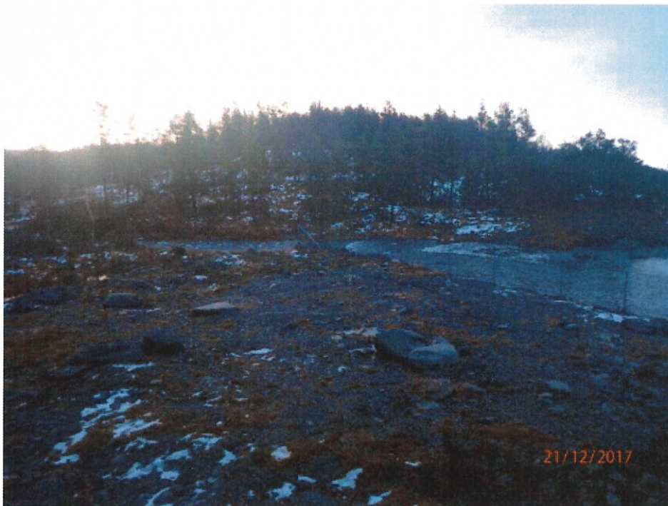
Bilde 4, tatt mot S, viser planert riggområde og strekning mellom Vikastølvatnet og inntaket
