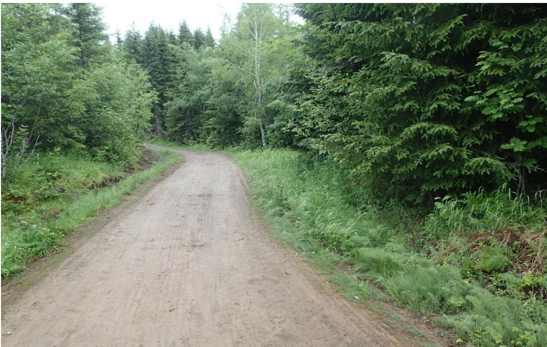
Langs rørgatetraséen som følger veien
