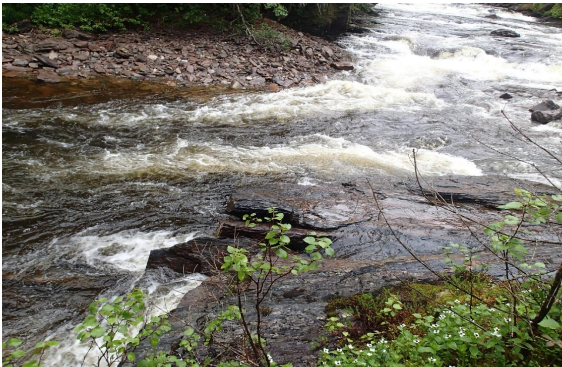
Inntaksområdet i Garbergselva (sett oppstrøms).
