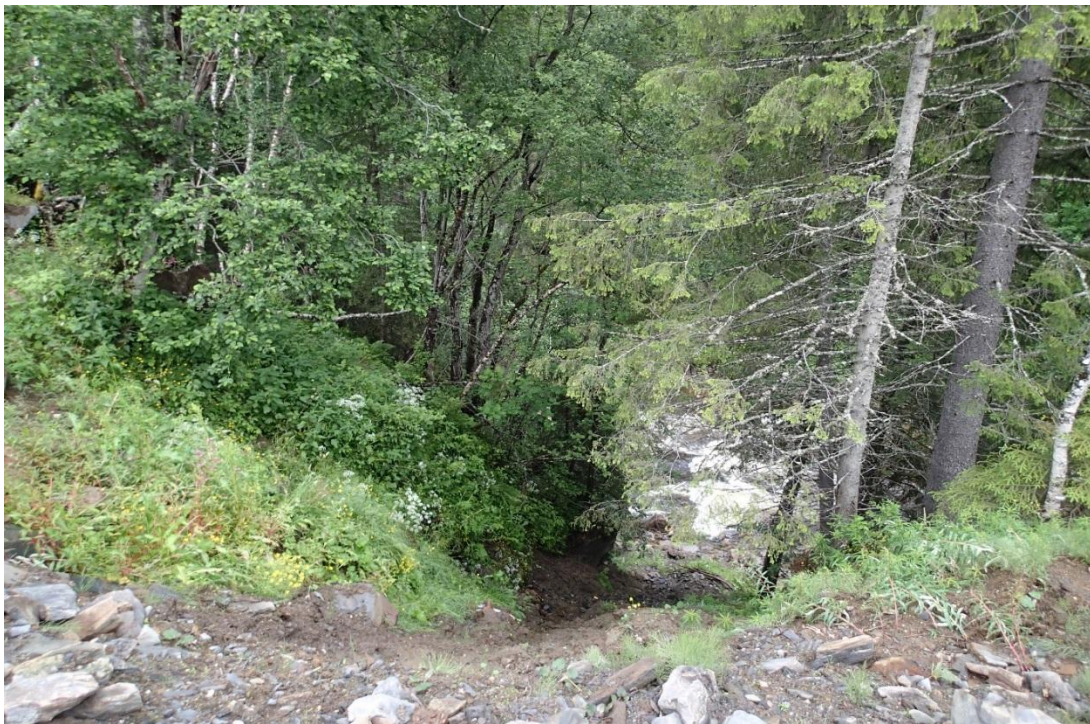
Langs Garbergselva oppstrøms inntaksområde. Spor etter utglidninger i terrenget.
