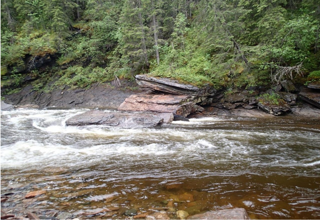
Damsted ved Garbergselva. Bart fjell synlig i elveløpet.
