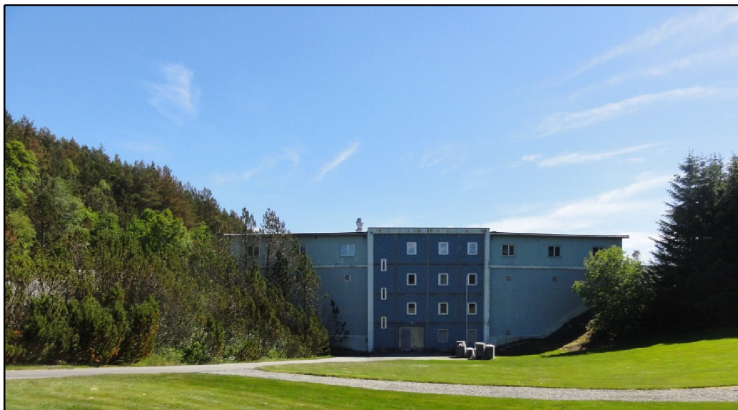
Figur 2-1. Langevatn dam i dag. Terrenget vil etter oppgradering av dam, bli hevet noe inn mot dammen på nedstrøms side.
