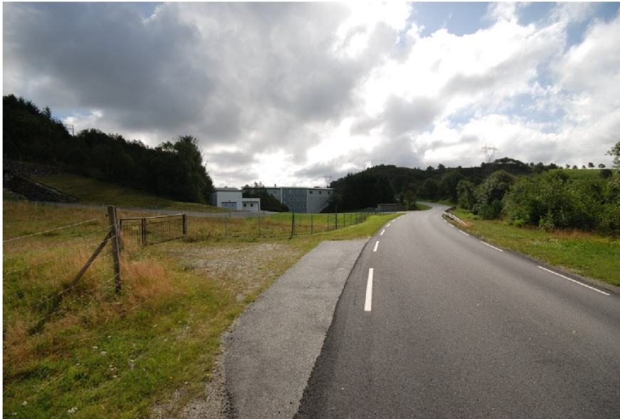
Figur 1-2. Langevatn dam sett fra fylkesveien i vest.
