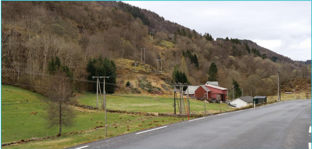
Figur 2-2 Eksisterende ledninger ved Søreid. 66 kV-ledningen til venstre og 22 kV-ledningen til Tysnes kraftlag til høyre i bildet. Foto: Norconsult.
