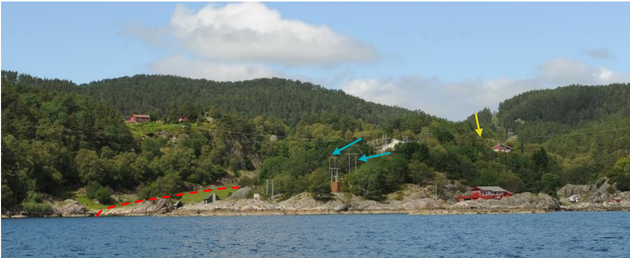
Figur 13-13. Oversikt over Otteråi. Blå pil indikerer ledningene som skal rives fram til eksisterende transformatorstasjon (gul pil). Stiplet rød linje viser ny kabeltrasé.
