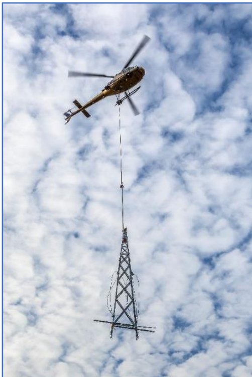
Figur 8-2. Etter premontering på riggplass flys mastene i deler ut til mastepunktet (bildet til venstre). Linene trekkes med vinsj (bilde til høyre) etter at pilotlinje er flydd ut med helikopter.
