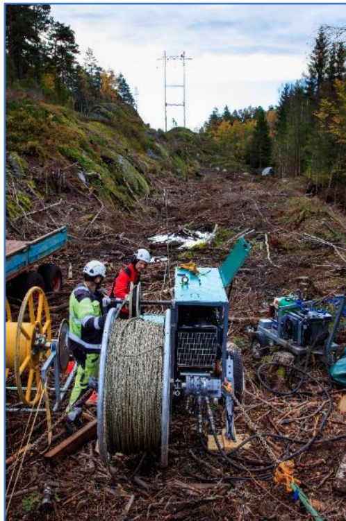
Figur 8-2. Etter premontering på riggplass flys mastene i deler ut til mastepunktet (bildet til venstre). Linene trekkes med vinsj (bilde til høyre) etter at pilotlinje er flydd ut med helikopter.
