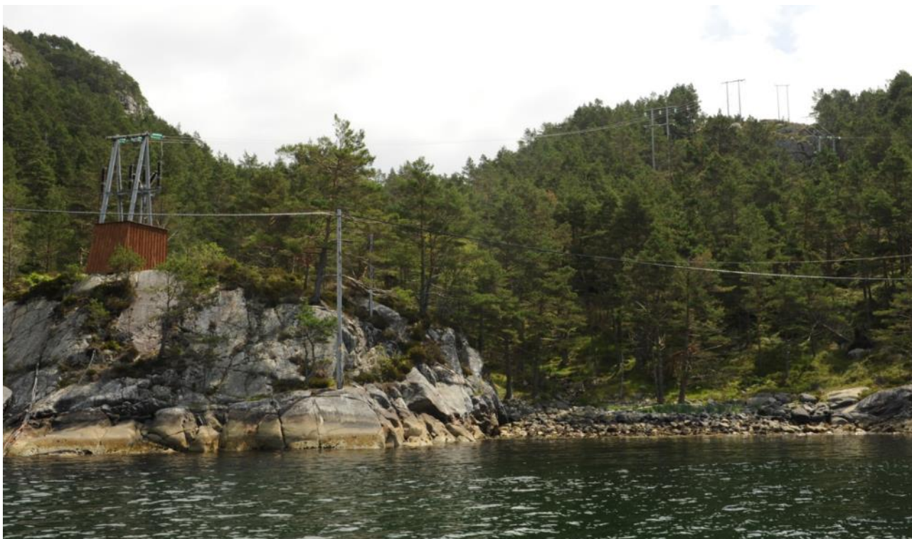
Figur 3-26. Ersvika, helt nord i delområdet, ved overgangen fra luftledning til sjøkabel
