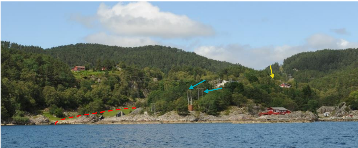
Figur 4-28. Oversikt over Otteråi. Blå pil indikerer ledningene som skal rives opp til eksisterende transformatorstasjon (gul pil). Stiplet rød linje viser ny kabeltrasé.
