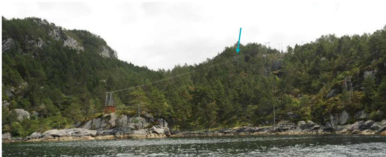
Figur 4-26. Ny ledning følger søkk i terrenget ned til Ersvika, pil viser ledningen som skal rives.
