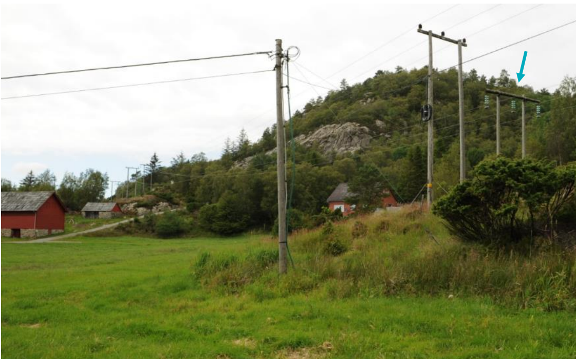
Figur 4-25 Ledningen til høyre i bildet skal rives.
