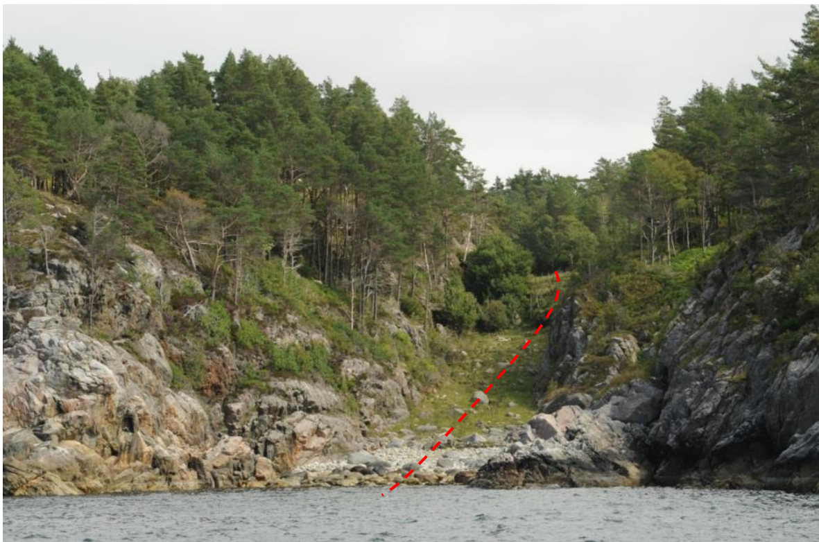
Figur 4-34. Stølsvika fra sjøsiden der kraftledning går fra kabelendemast til kabel.
