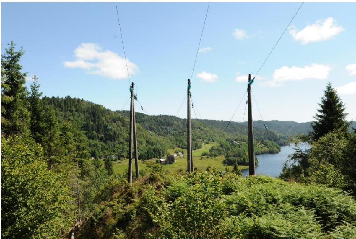
Figur 4-2 Eksisterende spennmaster ved vejen ved Gjerdehaugen med utsikt over Nordbustadvatnet vil rives når ledningen flyttes.
