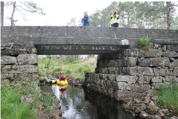
Figur 3-14 Bru over kanalen i Iselva
