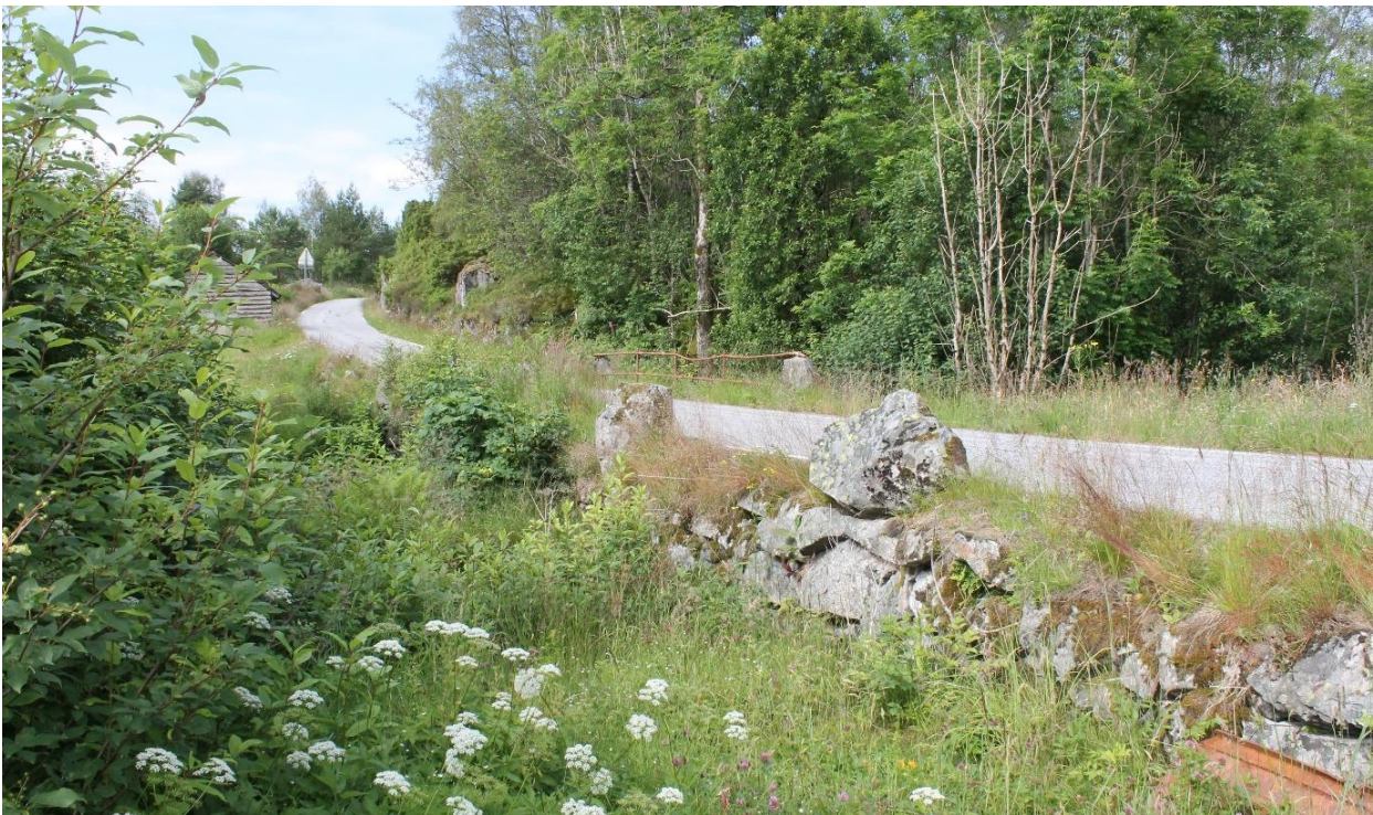
Figur 3-7 Vegen ved Kåstad.
