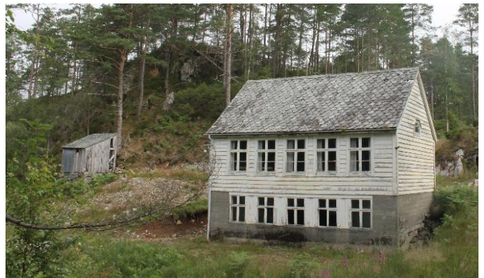
Figur 3-15 Tidligere bedehus ved Iselva
