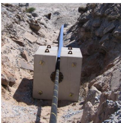
Figur 6-6: Betongblokk som strekkavlastning for sjøkabel til venstre og konsept for strekkavlastere til høyre
