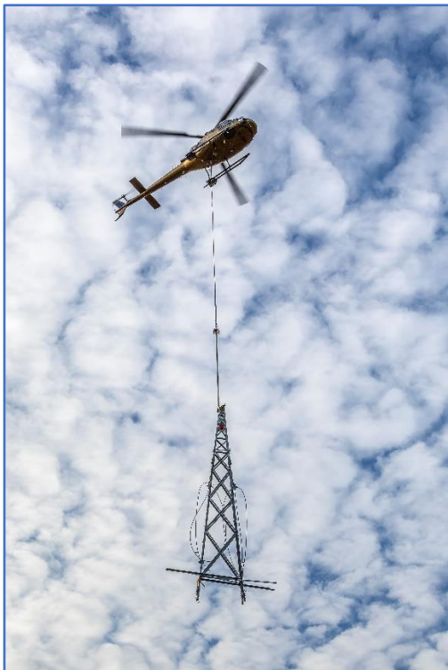
Figur 9-5: Etter premontering på riggplass flys mastene i deler ut til mastepunktet (bildet til venstre). Linene trekkes med vinsj (bilde til høyre) etter at pilotlinje er flydd ut med helikopter.
