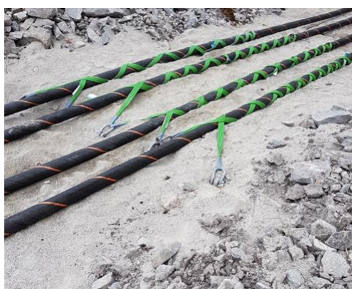
Figur 6-6: Betongblokk som strekkavlastning for sjøkabel til venstre og konsept for strekkavlastere til høyre
