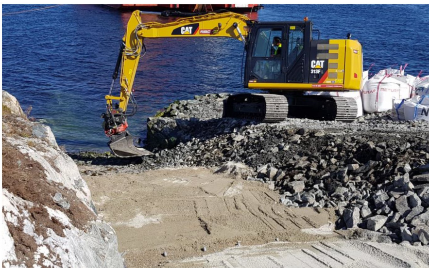
Figur 9-2: Graving av grøft og assistanse under uttrekk av kabel
