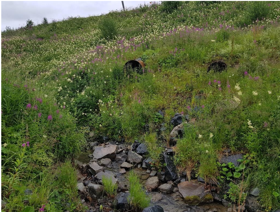
Figur 1: Utløp av overløpskulvertene gjennom jernbanefyllingen. Elva delvis steinsatt.
