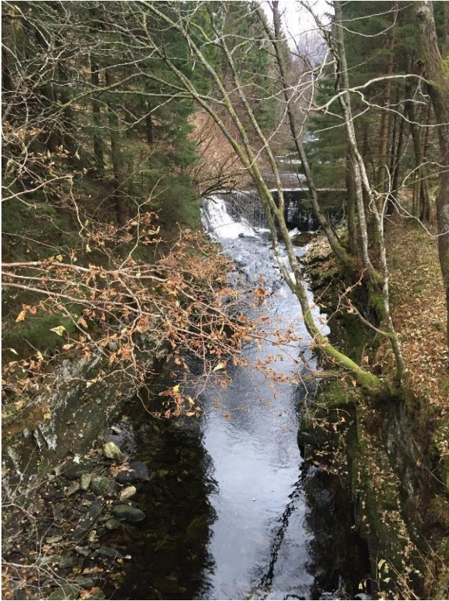
Bilde nr. 23. Bildet viser demningen i Kvia sett fra broen der fylkesvei 65 krysser elva.
