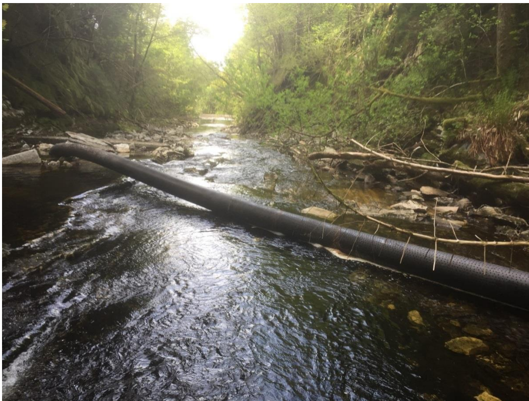
Bilde nr.18 Øverst i Kvia inntaksmagasin, dammen skimtes så vidt i bakgrunnen. Plastrøret, (Ø300) er det øverste inntaket til tidligere Ulvik settefisk anlegg. Dette punktet ligger ca. 3700m fra Ramsgrøvannet.
