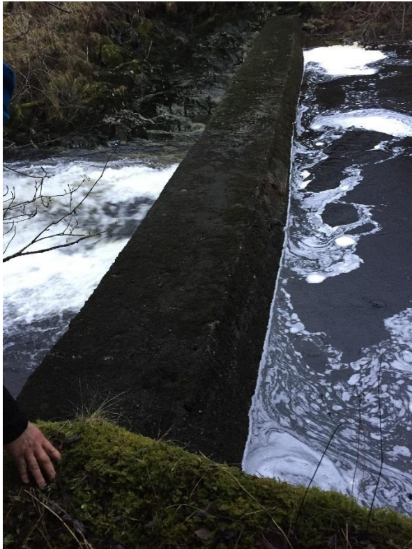
Bilde 16 a viser stor vannføring
