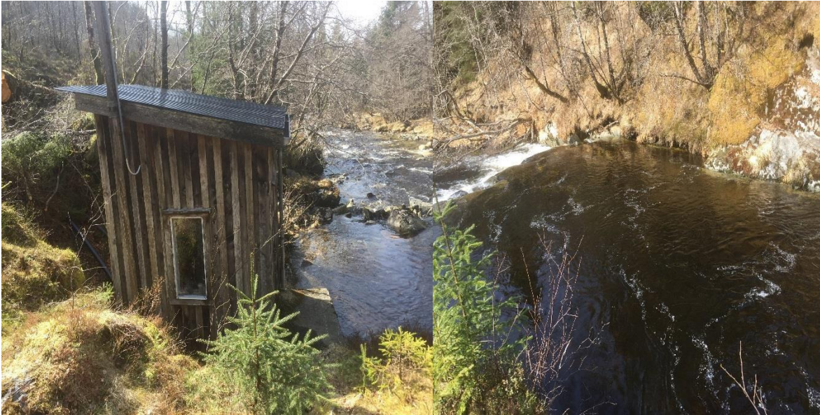
Bilde 14. Gammelt nedlagt privat pumpehus for vannforsyning til Sørbøvåg. Inntaksdam laget av store blokker. Kommunen overtok vassverket for en periode frem til nytt vassverk ble etablert.
