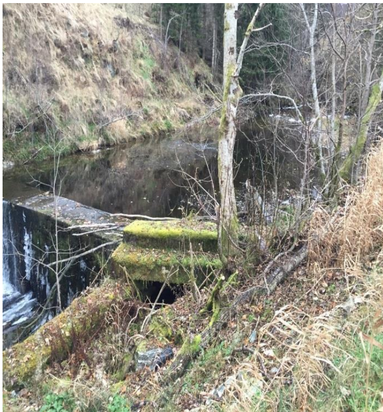
Bilde nr. 22a. Kviadammen, stor nok vannføring til at det renner over damkrona. Dammen ligger ca. 3,8 km fra Ramsgrøvannet.
