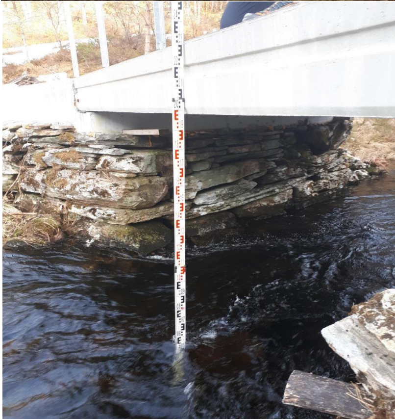
Bilde 6. Ny bro ca. 300 meter fra Ramsgrøvannet, Broen er etablert på tidligere landkar og har en lysåpning på 2,8 meter lengde og 1,95 meters høyde. Dette er den minste konstruksjonene langs elva.
