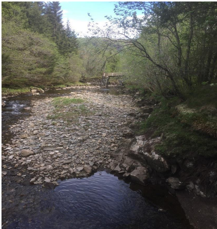
Bilde 17a. Utsyn fra betongdammen som vist i bilde 16 og mot trebroa se bilde 15.
