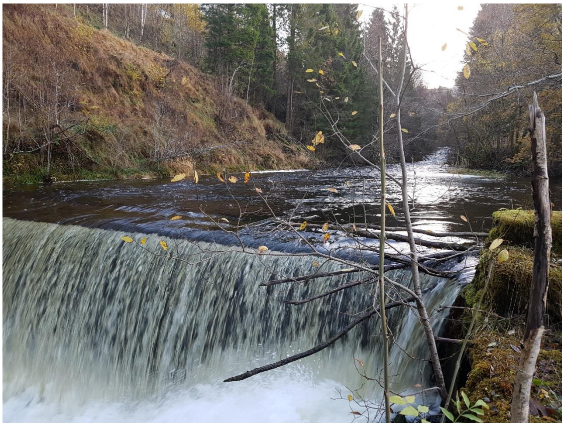
Figur 9. Kvia dam sett mot nord-øst. Foto: Sweco.
