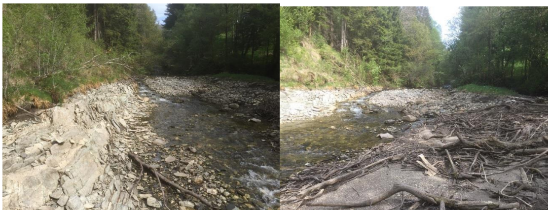
Bilde nr. 19. Utsyn mot henholdsvis venstre og høyre side i øvre del av inntaksbassenget i Kvia som gjennom årene har fått betydelig mengde av løsmasser. Bildet er tatt i mai 2018 med lav vannstand.
