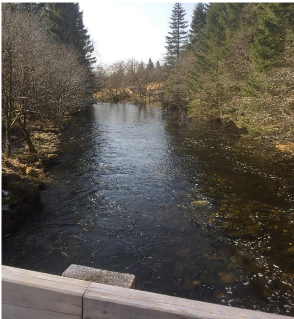
Bilde 15. trebro/gangbro og sikt mot bilde 16, broen benyttet som tursti.
