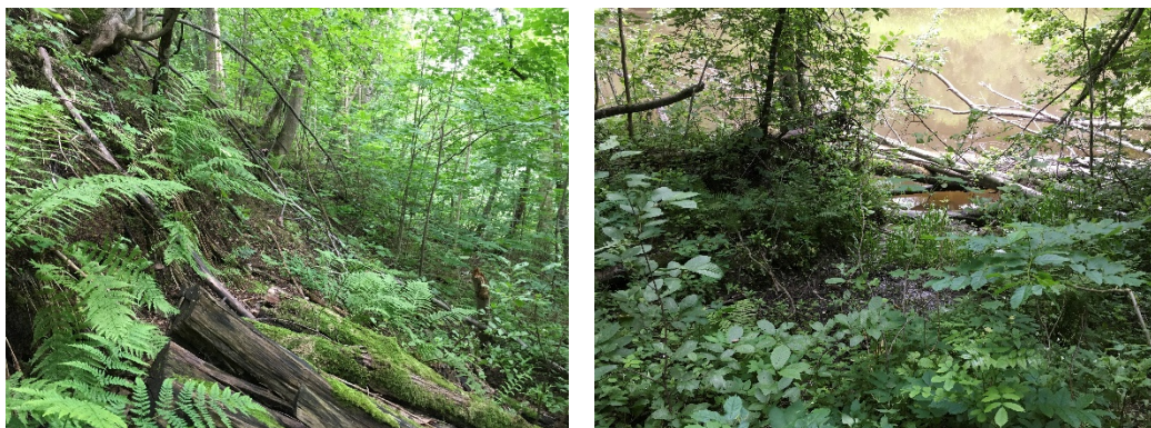
Figur 3 Sig/overflateutglidning i linje 2, bløtt og sig av vann i skråning i linje 4.
