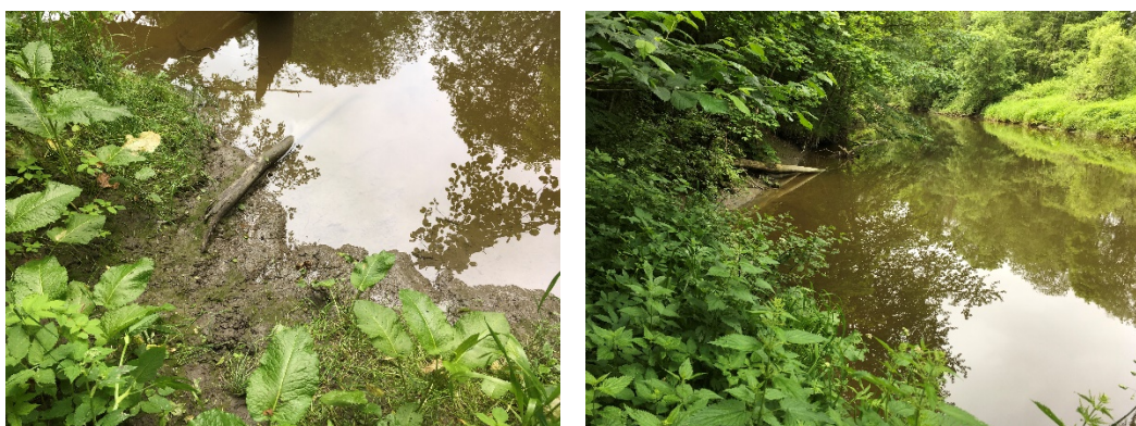
Figur 2 Erosjon i elvebredden, østsiden. Erosjon, leire i dagen.
