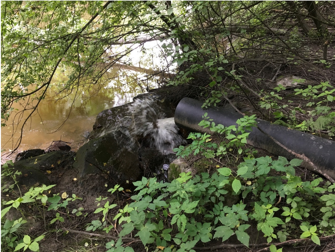
Figur 3 Drensrør og erosjonssikring ved Sandeelva, sør for skolebygningene.
