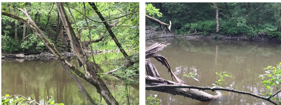
Figur 1 Steinsatt elvebredd på vestsiden. Lenger sørover noe erosjon i elvebredden, vestsiden.
