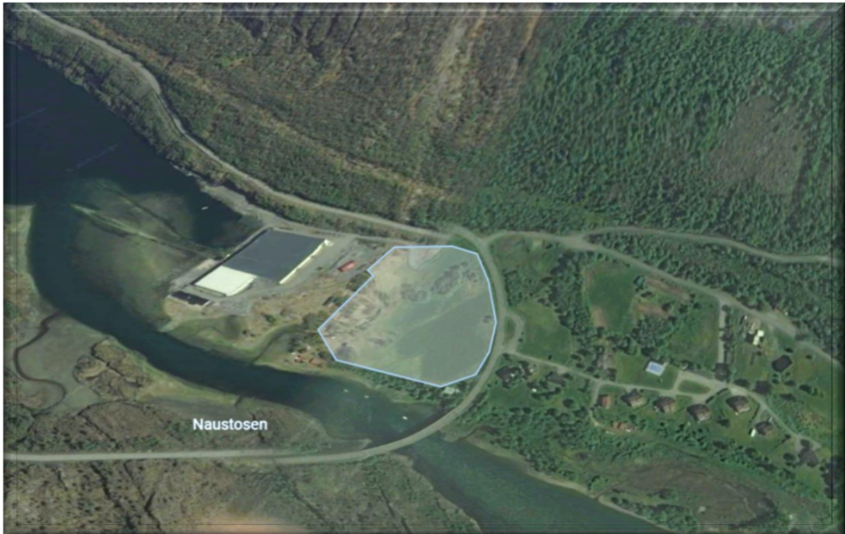
Bildet over viser industriområdet hvor datasenteret er planlagt.
