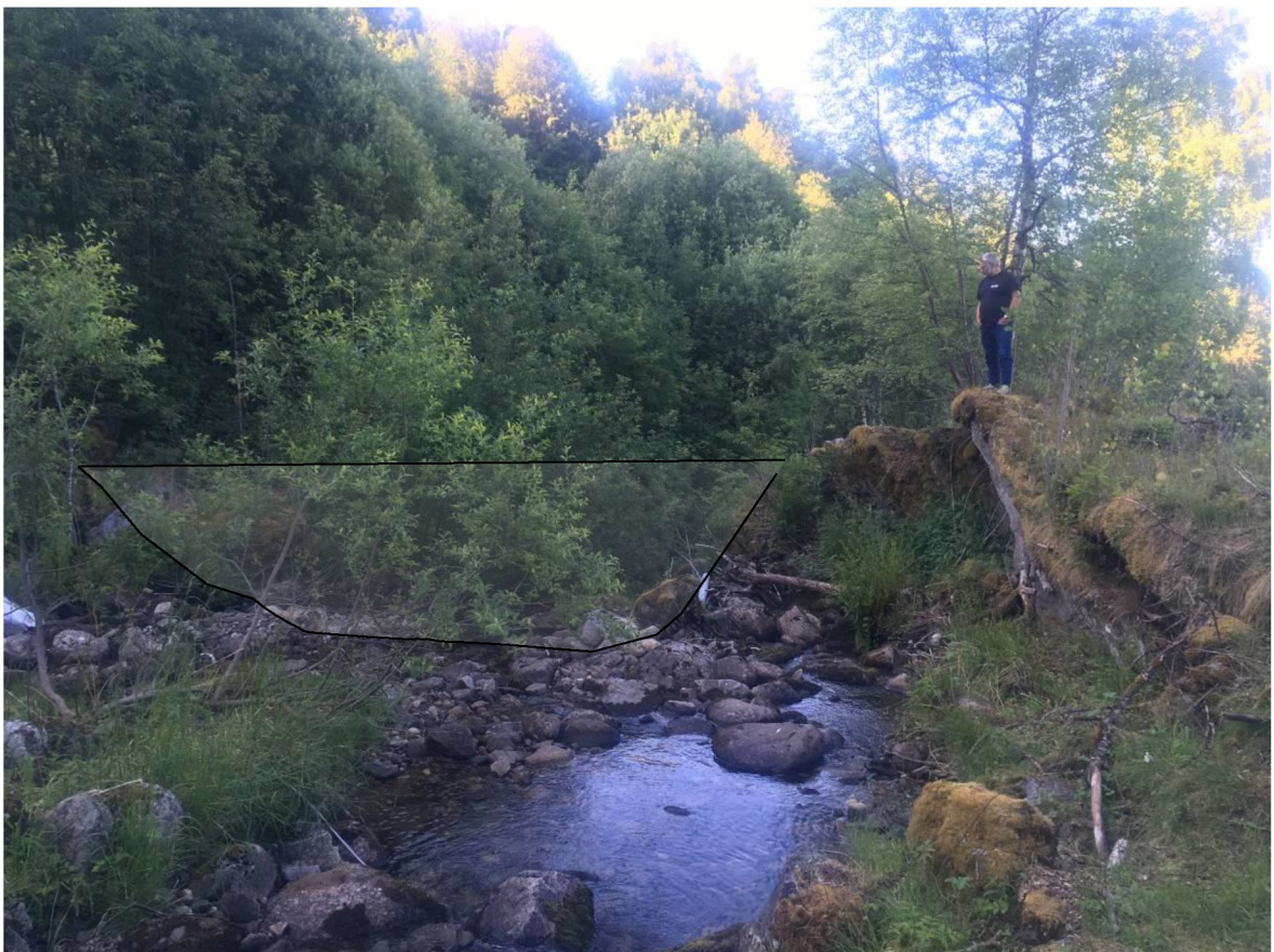
Bilde 2.2 Inntak sett ned mot dam
