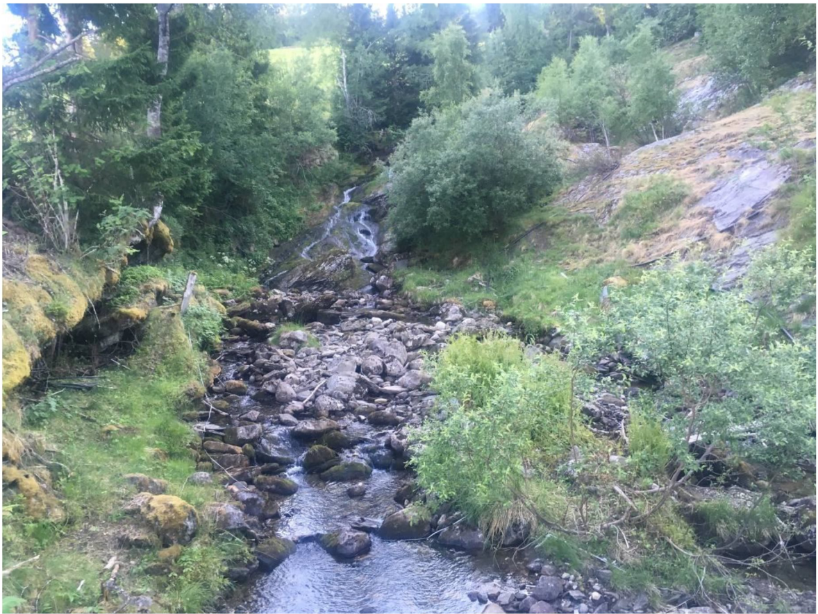
Bilde 2.1 Inntak ca kote 255 moh sett oppover fra dam
