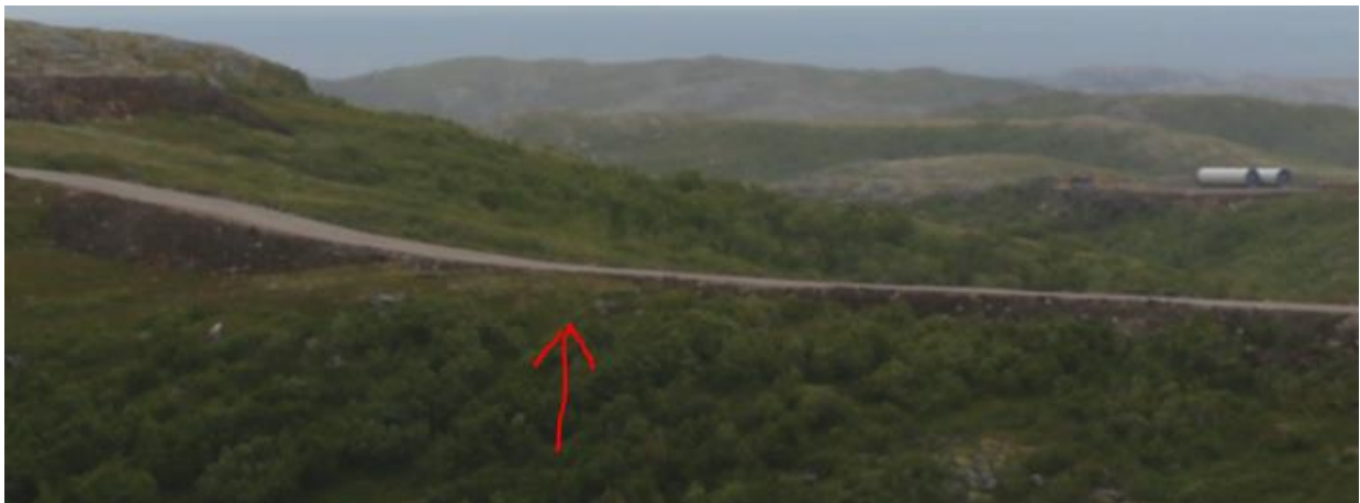
Figur 4. viser et eksempel hvor en vei er bygget på fylling, men hvor terrenget bryter fyllingen og hvor resultatet er en vei godt tilpasset landskapet (NVE).
