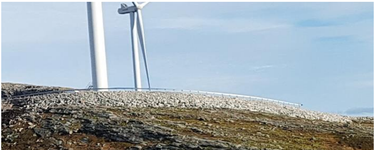
Figur 3. Veifylling etablert som «rydda røys». Veifyllingen skal ikke tilføres vekstmasse. Visuelt oppleves fyllingen som et tydelig avgrenset inngrep (NVE).
